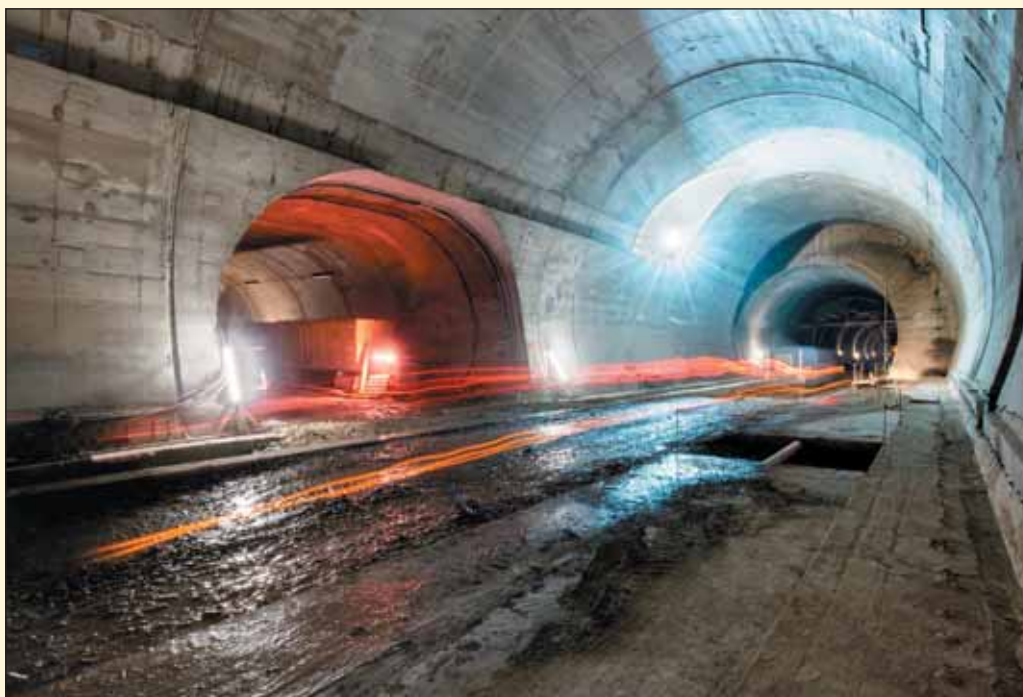
Obr. 4 Pohľad do núdzového zálivu NZ-3J v tuneli Višňové Fig. 4 A view down the emergency lay-by NZ-3J in the Višňové tunnel
