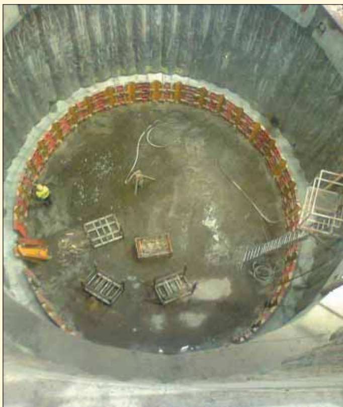
Obr. 2 Pohled na dno přístupové šachty pro stanici Olbrachtova Fig. 2 A view down the bottom of the access shaft for Olbrachtova station
