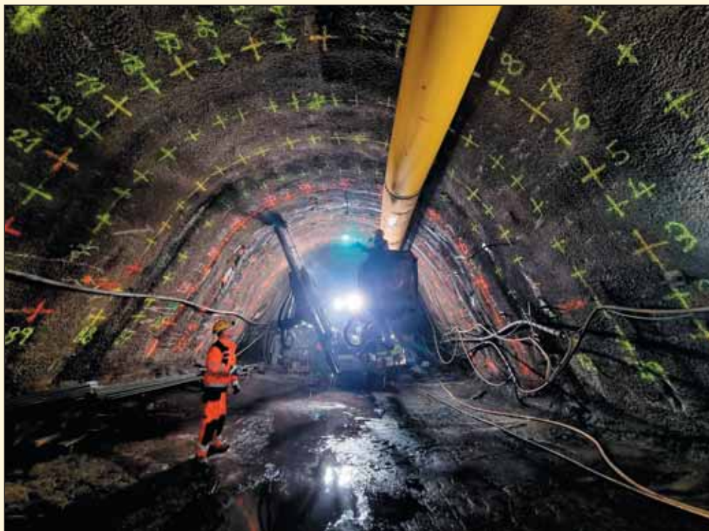
Obr. 1 Realizace chemických injektáží v patní štole stanice Pankrác Fig. 1 Chemical grouting in the toe adit of Pankrác station
