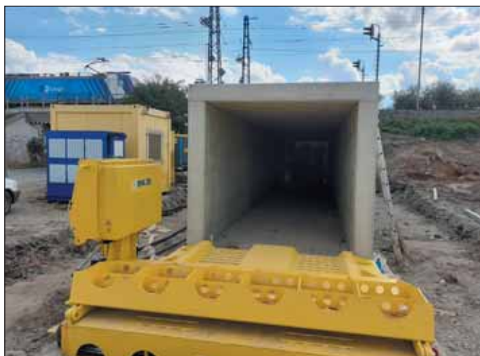
Obr. 3 Protlačecí souprava před zahájením ražby Fig. 3 Jacking rig before the commencement of excavation
