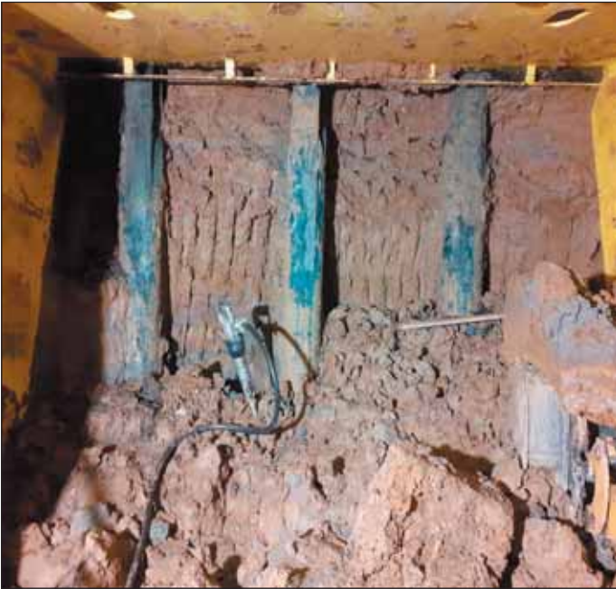
Obr. 5 Profily HEB původního záporového pažení zastižené na čelbě Fig. 5 HEB sections of the original soldier beam and lagging bracing encountered at the excavation face
