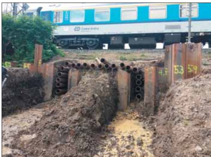
Obr. 1 Dokončený ochranný deštník Fig. 1 Completed canopy tube pre-support
