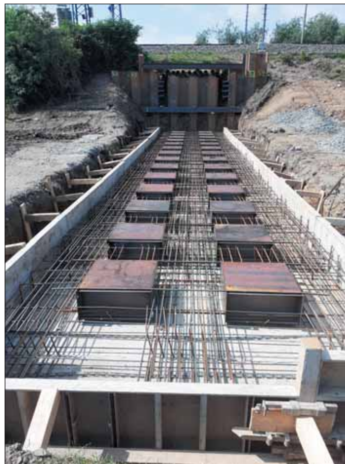
Obr. 2 Technologická rampa před betonáží Fig. 2 Technology ramp before concreting
