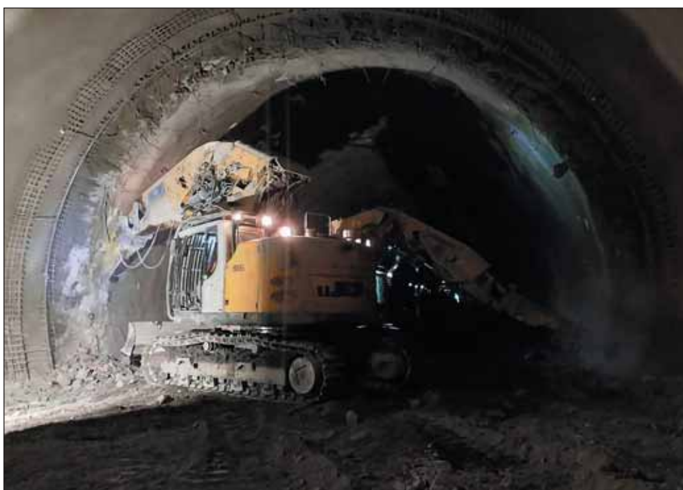
Obr. 8 Sanácia NZ 1 – odstránenie primárneho ostenia v celom profile po záberoch Fig. 8 Rehabilitation NZ 1 – round-by-round removal of primary lining in the entire profile
