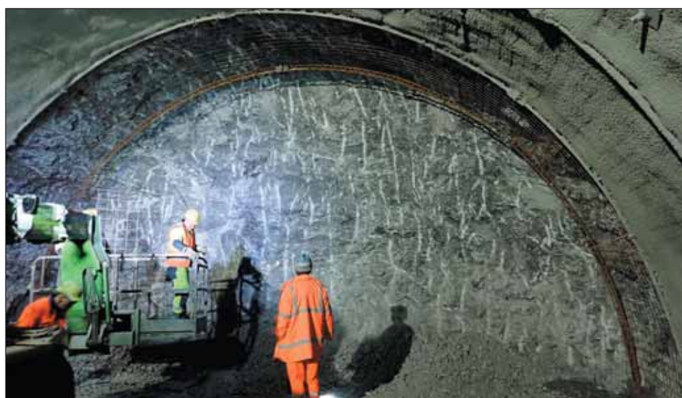
Obr. 5 Čelba kaloty v slienitých vápencoch Fig. 5 Top heading excavation face in marlaceous limestone
