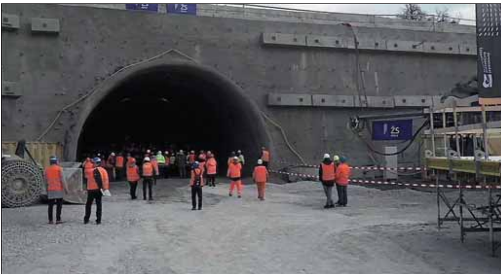
Obr. 7 Západný portál – prerazenie pravej tunelovej rúry
