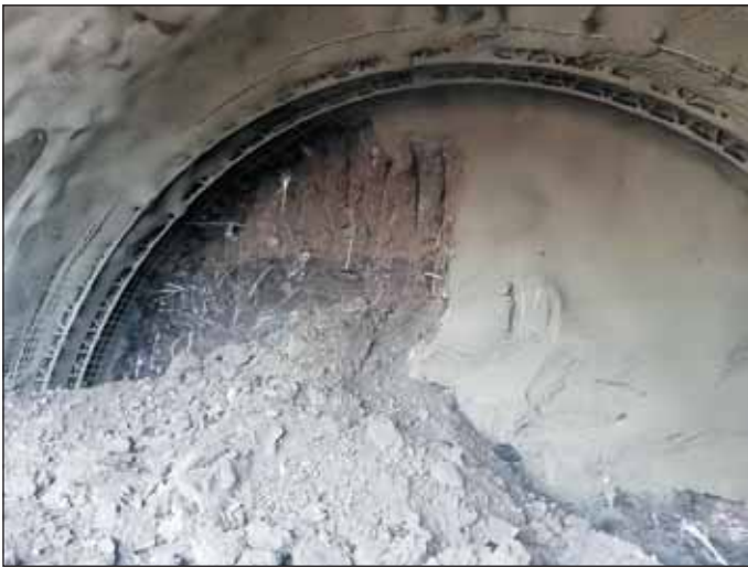
Obr. 6 Čelba kaloty v úseku od západného portálu s kvartérom zasahujúcim do razeného profilu
