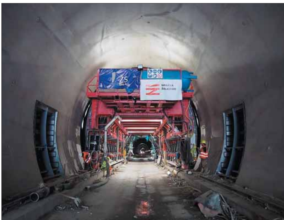
Obr. 11 Pojízdné ocelové bednění pro betonáž horní klenby Fig. 11 Mobile steel traveller formwork for concreting the upper vault
