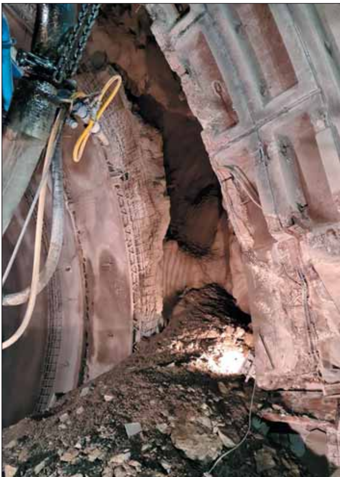
Obr. 7 Nadvýlom 17. 05. 2022 Fig. 7 Overbreak 17. 05. 2022
