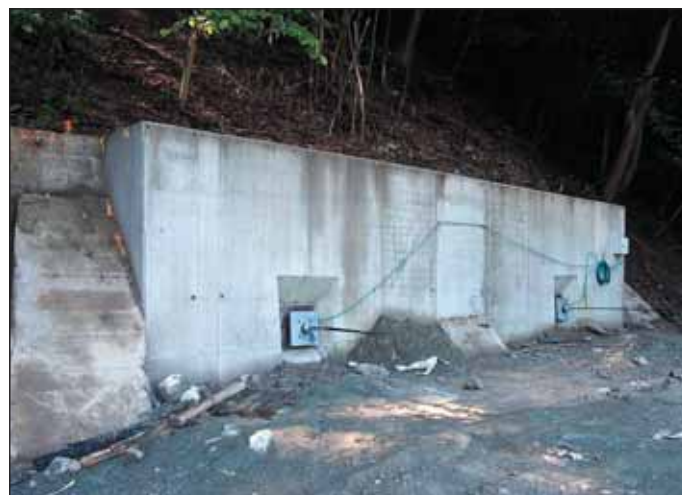
Obr. 10 Kotvený železobetonový práh nad blanenským portálem P2 Fig. 10 Anchored reinforced concrete block above Blansko portal P2
