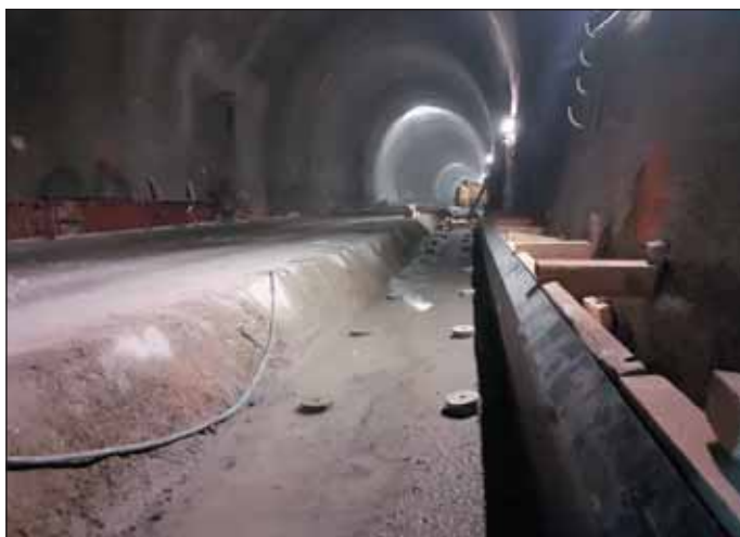
Obr. 12 Příprava pro armování a betonáž základového pásu Fig. 12 Preparation for installation of reinforcement and concreting of a foundation strip
