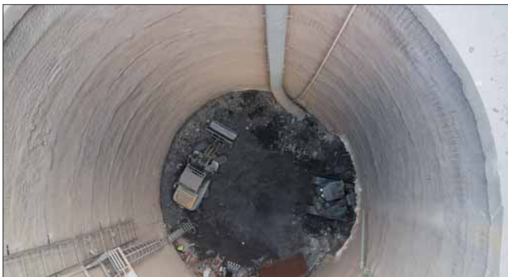
Obr. 4 Pohled na dno šachty Š1 při ražbě přestupní chodby UPCH Fig. 4 View of the bottom of shaft Š1 during the excavation of the UPCH transfer corridor
