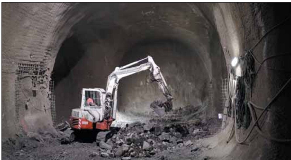
Obr. 5 Křížení ražených profilů v UPCH Fig. 5 Crossing of excavated profiles in UPCH
