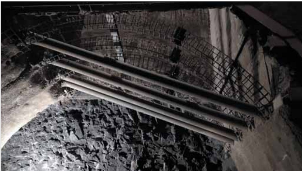
Obr. 7 Rozpěry v průniku šachty Š2.2 a profilu G Fig. 7 Struts at the intersection of shaft Š2.2 and profile G
