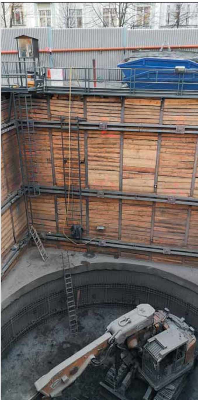
Obr. 3 Hloubení šachty Š1 ze dna stavební jámy Fig. 3 Excavation of shaft Š1 from the bottom of the construction pit
