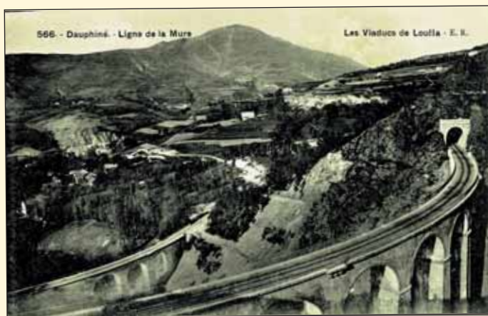
Obr. 5 566 Dauphiné – Dráha ve stěně (Ligne de la Mure) – Viadukt Loulla. ?? Kolem 1920 [sbírka autorů].
