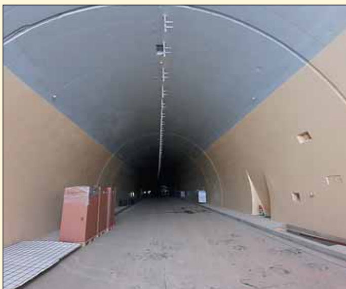
Obr. 5 Pohľad do tunelovej rúry tunela Bikoš Fig. 5 View down the Bikoš tunnel tube
