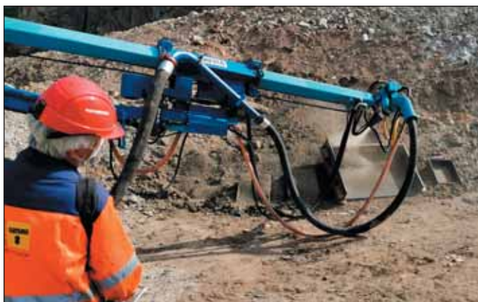
Obr. 4 Nástřik zkušební desky z vláknobetonu na stavbě
