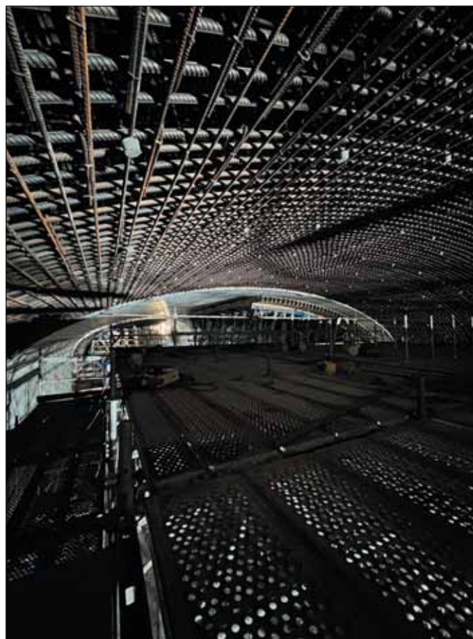
Obr. 6 Armokoš výztuže před posunem formy bednění Fig. 6 Reinforcement cage before shifting of formwork
