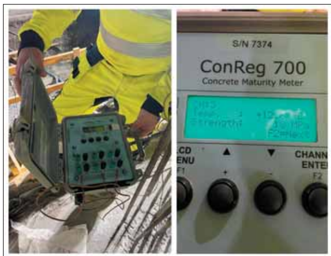
Obr. 10 Měření zralosti betonu pro stanovení času odbednění konstrukce Fig. 10 Measurement of concrete curing state for determination of formwork striking time
