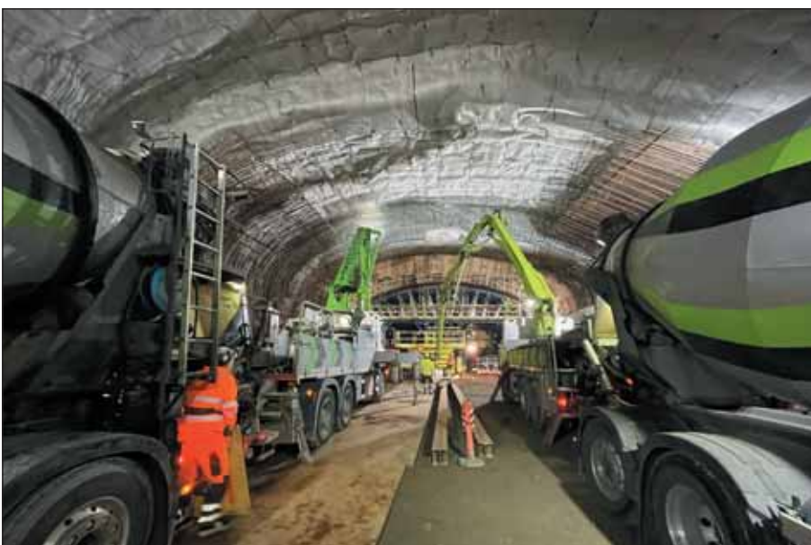
Obr. 9 Betonáž klenby ostění dvěma betonovými pumpami Fig. 9 Concreting the lining vault by two concrete pumps
