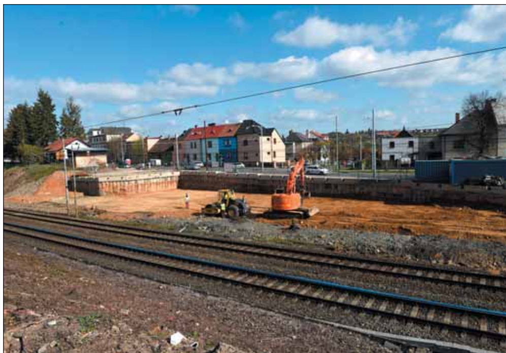
Obr. 8 Stavební jáma Fig. 8 Construction pit
