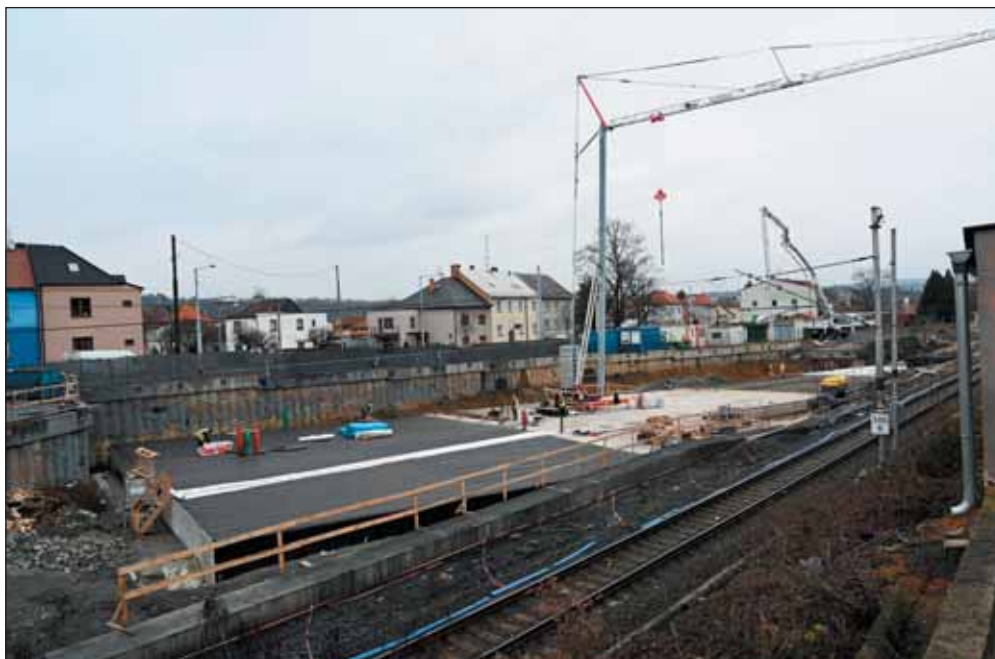
Obr. 6 Izolace stropní desky Fig. 6 Roof deck waterproofing
