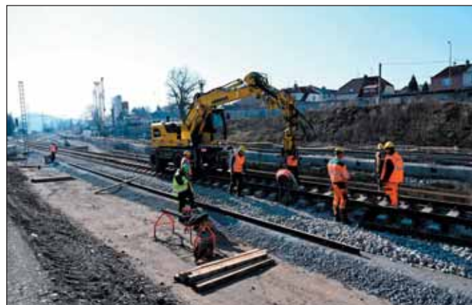
Obr. 9 Budování objízdné trasy Fig. 9 Construction of by-pass route
