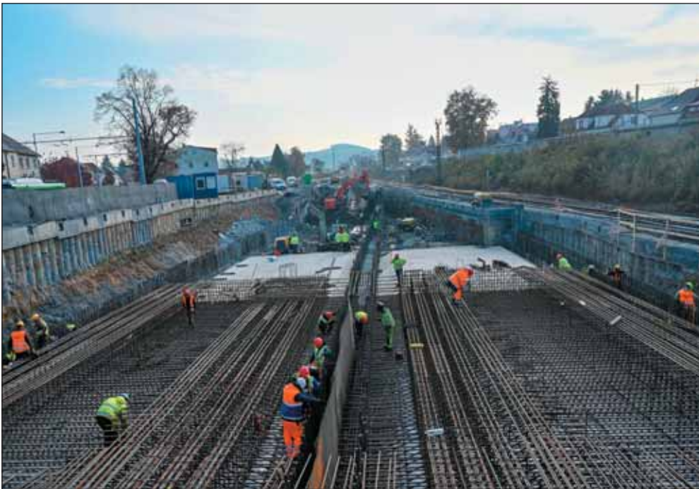
Obr. 10 Armování 1. dilatace a podklad pro 2. dilataci
