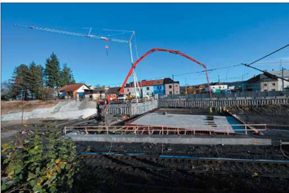
Obr. 11 Betonáž dilatačního dílu 1
