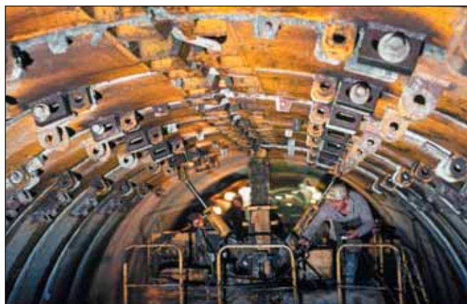
Obr. 8 Bednicí sekce mechanizovaného štítu TŠČB-3 Fig. 8 Formwork section of the mechanised shield TŠČB-3
