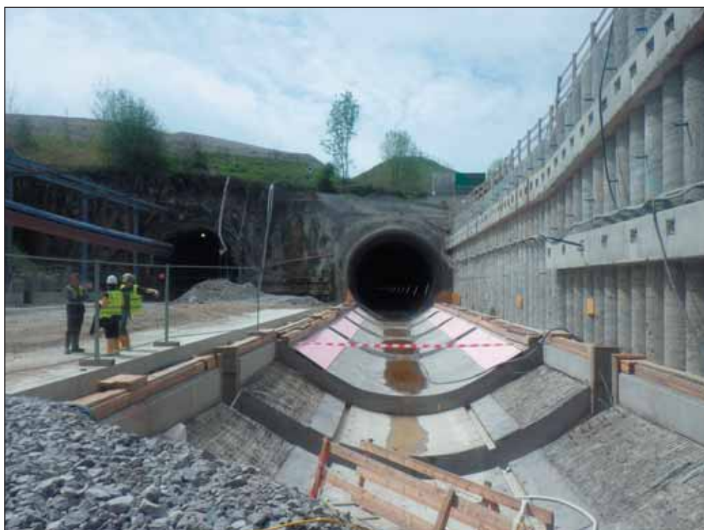
Obr. 4 Tunel Koralm – startovací lože pro razičící stroj v jámě Mitterpichling
