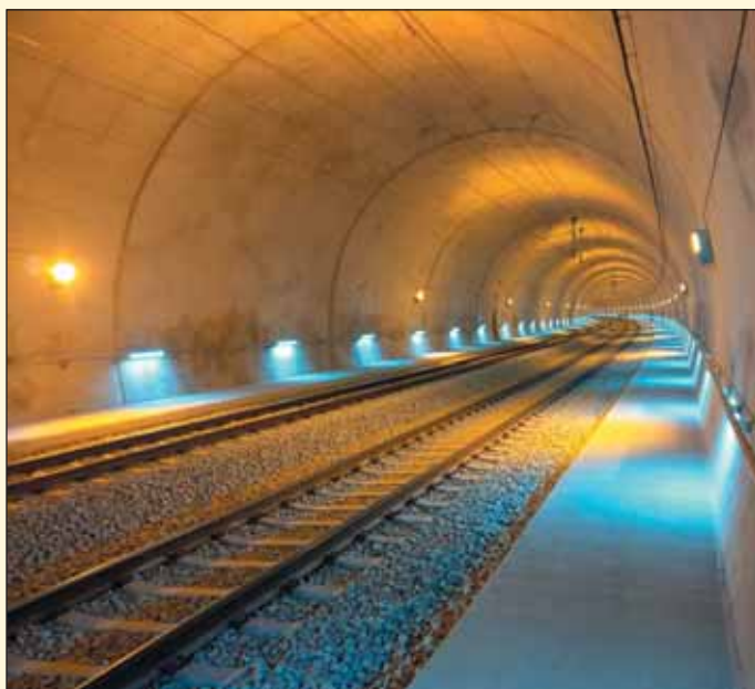
Obr. 7 Ukončené práce v tuneli Diel Fig. 7 Finished work in Diel tunnel
