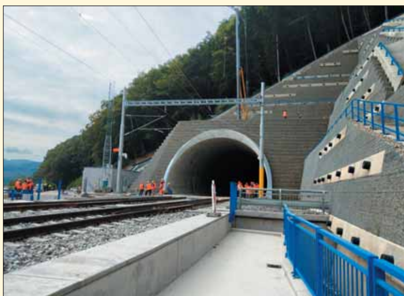
Obr. 8 Východný portál tunela Diel Fig. 8 Eastern portal of Diel tunnel
