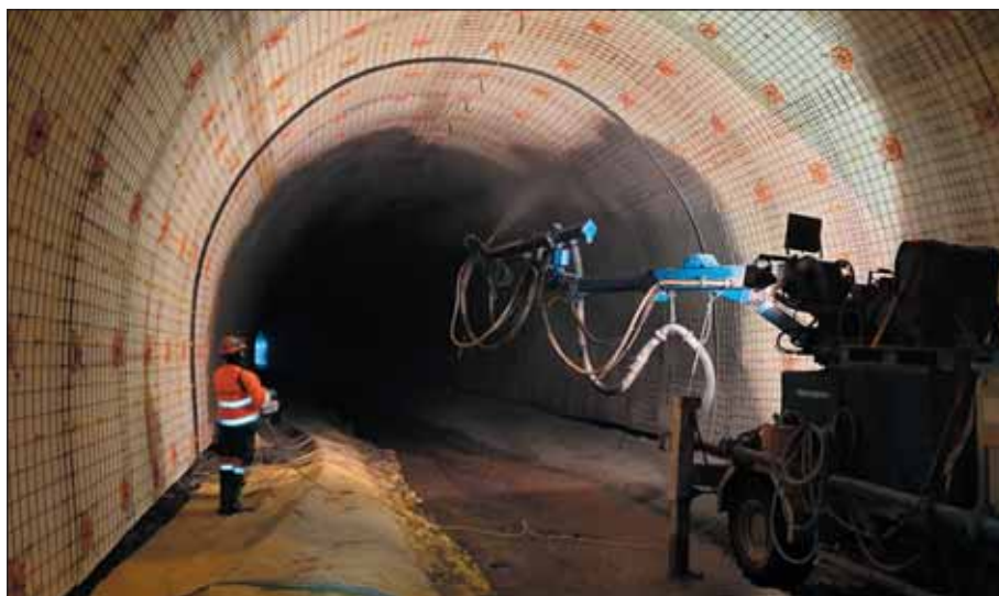
Obr. 8 Aplikace stříkaného betonu na KARI síť Fig. 8 Application of shotcrete on KARI welded mesh
