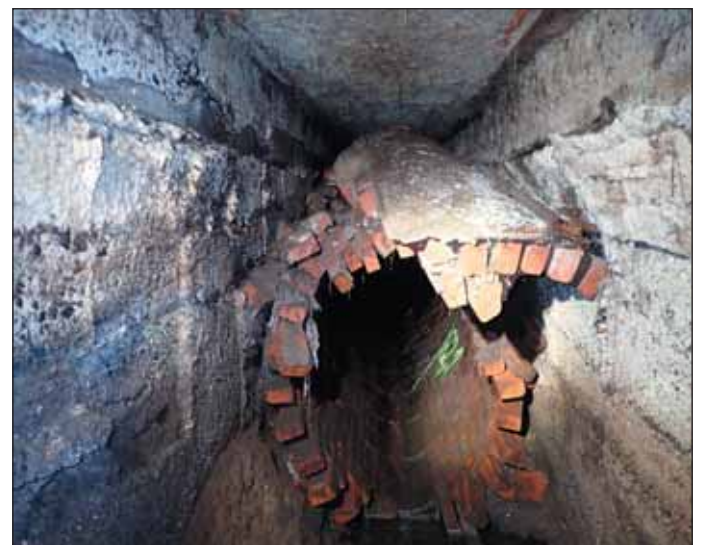
Obr. 11 Porušení celistvosti stoky vedené v betonovém kanálu Fig. 11 Broken integrity of a sewer running inside a concrete channel
