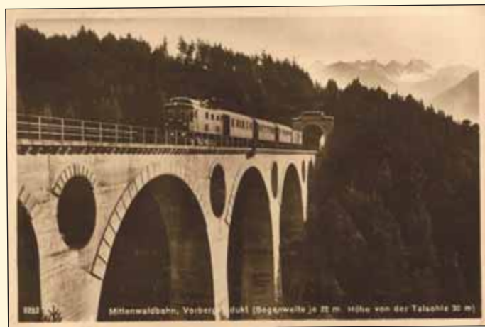
Obr. 5 5253 Mittenwaldská dráha. Viadukt Vorberg (šířky oblouku 22 m, s výškou nad údolím 30 m). Alpiner Kunstverlag Wilhelm Stempfle, Innsbruck. 1941. [sbírka autorů]
