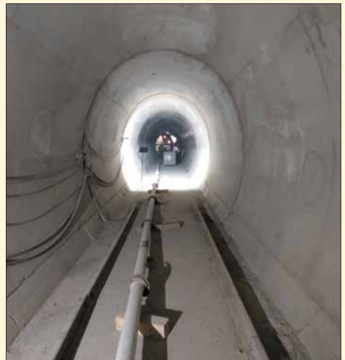
Obr. 6 Betonáž sekundárneho ostenia únikovej štôľne Diel Fig. 6 Concreting the secondary lining in the escape gallery of the Diel tunnel
