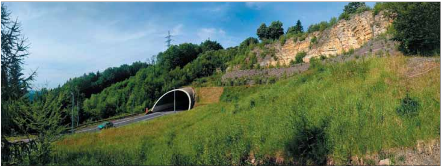
Obr. 16 Celkový pohled na východní portál tunelu Hřebeč (aktuální stav) Fig. 16 Overall view of eastern portal of the Hřebeč tunnel (current condition)
