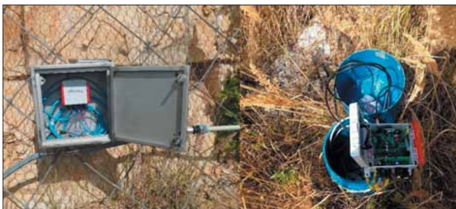
Obr. 15 Umístění datalogerů – skalní stěna a „falešný“ vrt Fig. 15 Placement of data loggers – the rock wall and a “false” borehole
