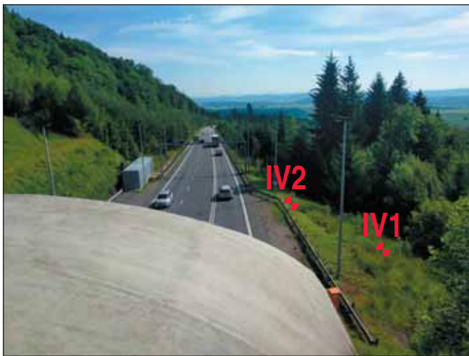
Obr. 5 Pohled z východního portálu směrem na Moravskou Třebovou s inklinometry pod silnicí
