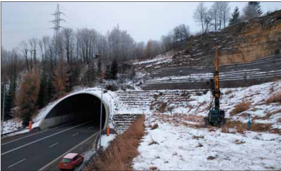
Obr. 10 Provádění vrtu pro osazení nových snímačů pórového tlaku – 2016 Fig. 10 Drilling holes for installation of new pore pressure transducers – 2016
