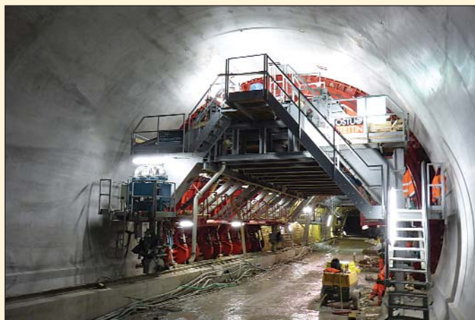
Obr. 6 Tunel Ovčiarsko – sekundárne ostenie Fig. 6 Ovčiarsko tunnel – secondary lining
