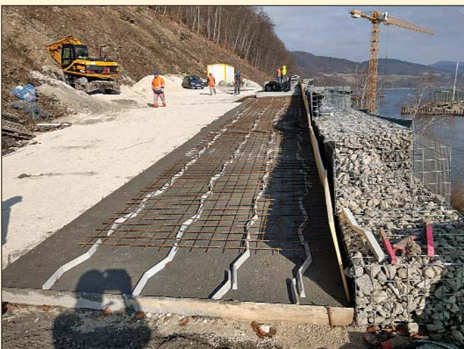
Obr. 10 Prístupová komunikácia na východný portál tunela Diel Fig. 10 Access road to the eastern portal of the Diel tunnel
