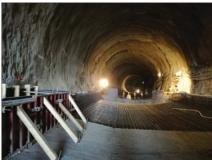
Obr. 5 Realizácia spodnej klenby tunela Fig. 5 Realisation of tunnel invert
