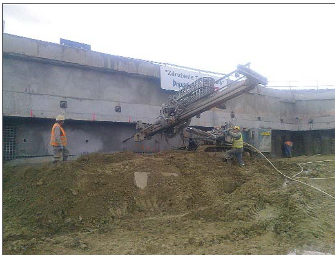
Obr. 3 Osadzovanie zemných klyncov medzi mikropilótami nad čelbou južnej tunelovej rúry
