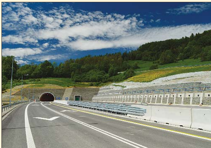
Obr. 1 Tunel Poľana – východný portál Fig. 1 Polana tunnel – eastern portal
