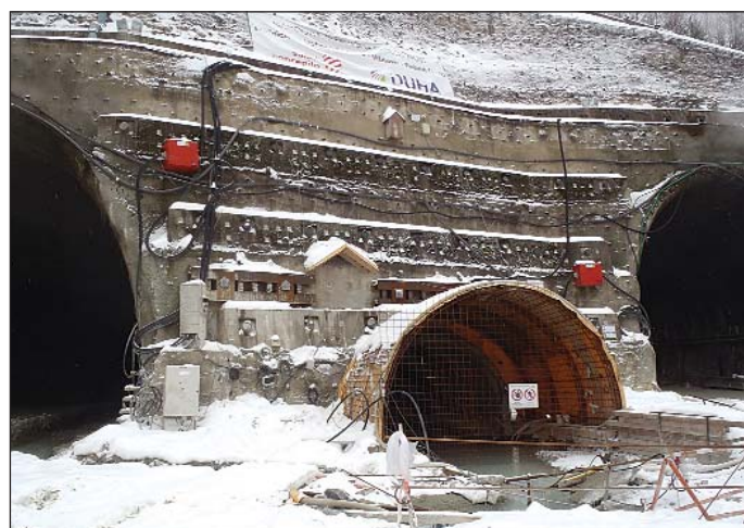
Obr. 4 Vyústenie odvodňovacej štólne na východnom portáli Fig. 4 Drainage gallery mouth at the eastern portal
