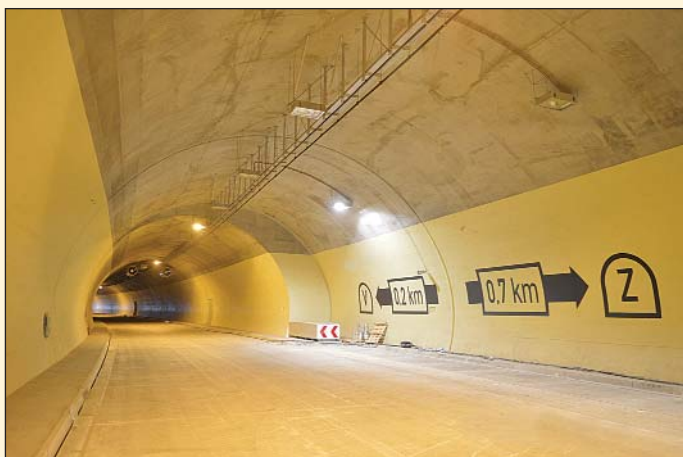
Obr. 3 Tunel Poľana – cestný tunel Fig. 3 Polana tunnel – road tunnel
