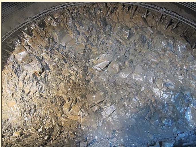
Obr. 11 Tunel Milochove, čelba tvorená striedanými vrstvami ílovcov a pieskovcov
