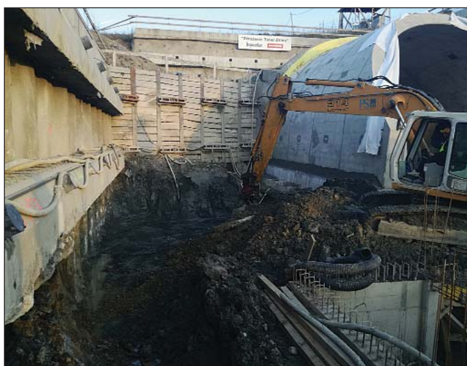
Obr. 7 Výkop pre základové pásy obkladových a zárubňových múrov, po pravej strane základová konštrukcia pre rozvodňu NN Fig. 7 Excavation for continuous footing of cladding and revetment walls, foundation structure for the LV substation pictured right
