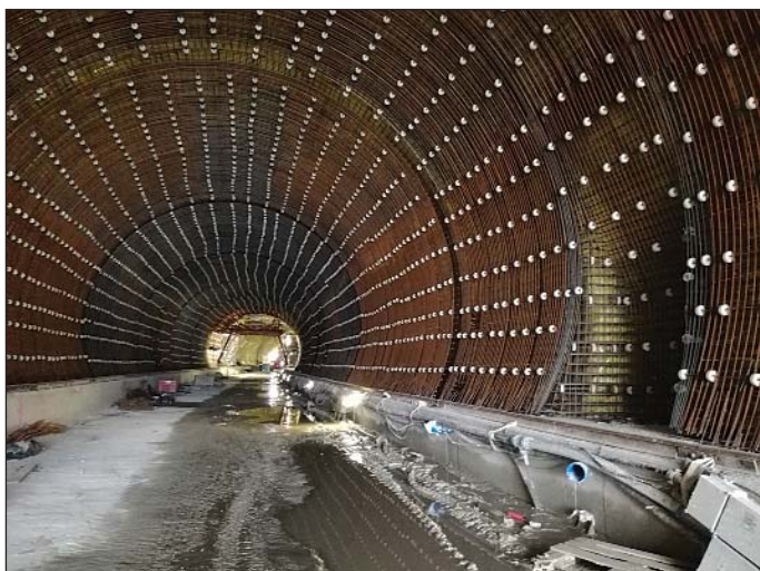
Obr. 6 Pohľad na výstuž hornej klenby sekundárneho ostenia Fig. 6 A view of the reinforcement of the upper vault of the secondary concrete lining
