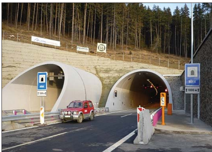
Obr. 1 Tunel Bôrik Fig. 1 Bôrik tunnel
