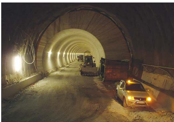
Obr. 3 Sekundárne ostenie tunela v úseku pred núdzovým zátlivom Fig. 3 Secondary lining of the tunnel in the section before the emergency lay-by
