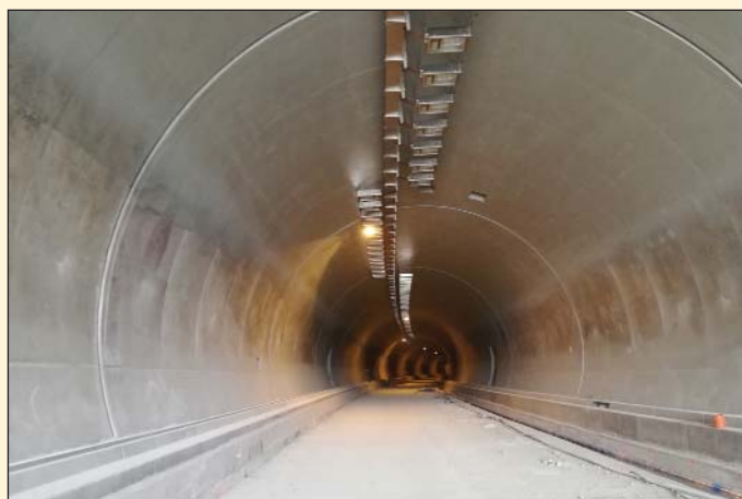
Obr. 4 Tunel Žilina – dokončovacie práce Fig. 4 Žilina tunnel – finishing work
