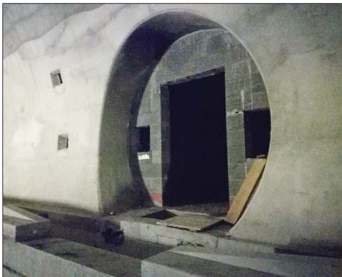
Obr. 8 Murovaná stena priečneho prepojenia Fig. 8 Masonry wall of the cross passage
