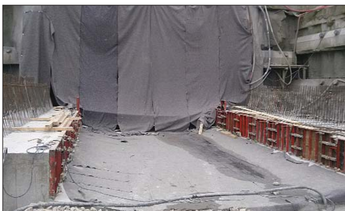
Obr. 5 Pohľad na spodnú klenbu hĺbeného tunela na západnom portáli Fig. 5 A view of the invert of the cut-and-cover tunnel at the western portal
