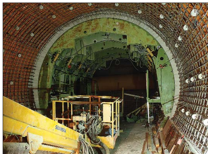
Obr. 6 Realizácia sekundárneho ostenia vo vetracom kanáli Fig. 6 Installation of secondary lining in the ventilation duct
