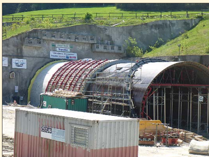
Obr. 8 Tunel Ovčiarsko – západný portál (JTR) Fig. 8 Ovčiarsko tunnel – western portal (STT)
