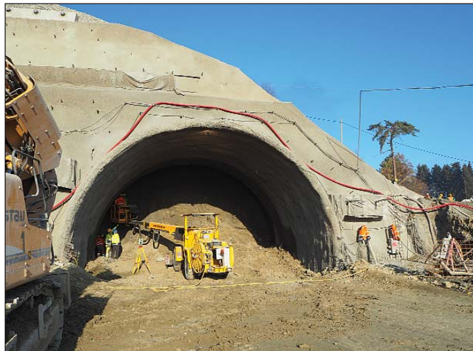
Obr. 2 Začiatok razenia – východný portál Fig. 2 Beginning of tunnel excavation – eastern portal
