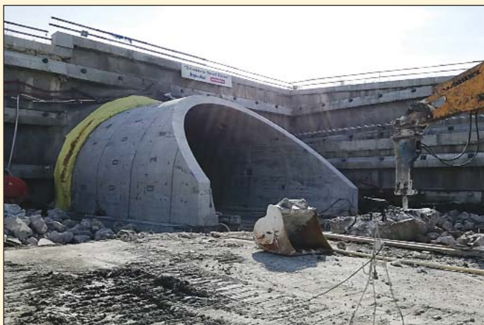
Obr. 5 Tunel Žilina – západný portál (JTR) Fig. 5 Žilina tunnel – western portal (STT)
