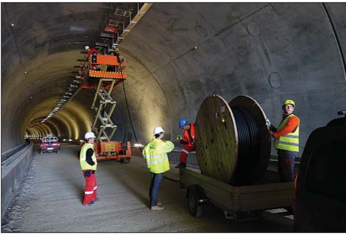
Obr. 9 Montáž anténneho kábla Fig. 9 Installation of the antenna cable
