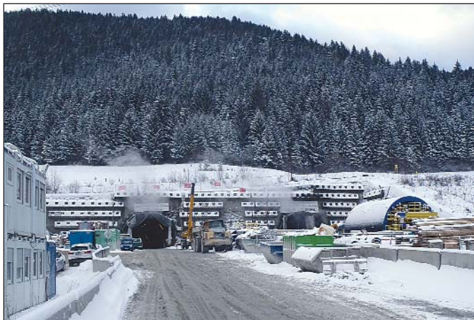
Obr. 1 Pohľad na stavenisko na západnom portáli tunela Višňové Fig. 1 A view of the construction site at the western portal of the Višňové tunnel
