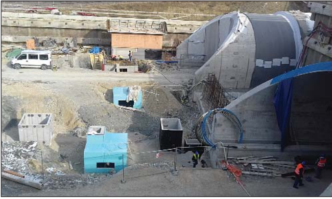
Obr. 6 Západný portál – pohľad na prebiehajúce práce 03/2018 Fig. 6 Western portal – a view of the work underway, March 2018
