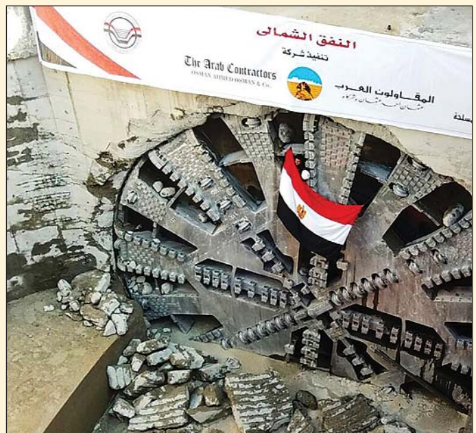
Obr. 6 Prorážka druhé tunelové trouby u Port Saidu 14. 12. 2017
