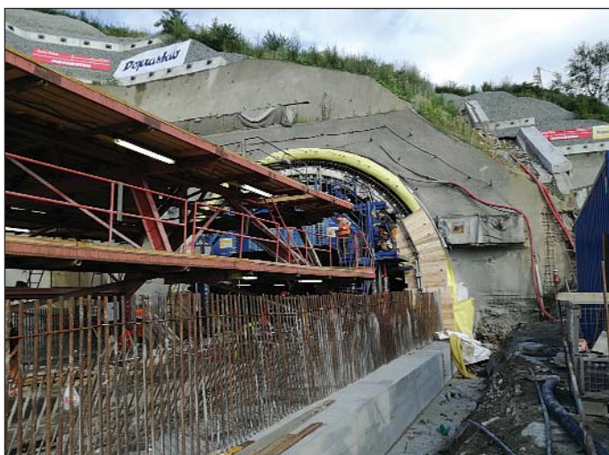
Obr. 5 Realizácia hĺbeného tunela na východnom portáli Fig. 5 Realisation of cut-and-cover tunnel at the eastern portal
