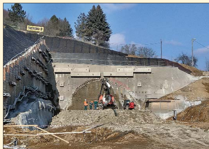
Obr. 13 Tunel Milochove, východný portál
