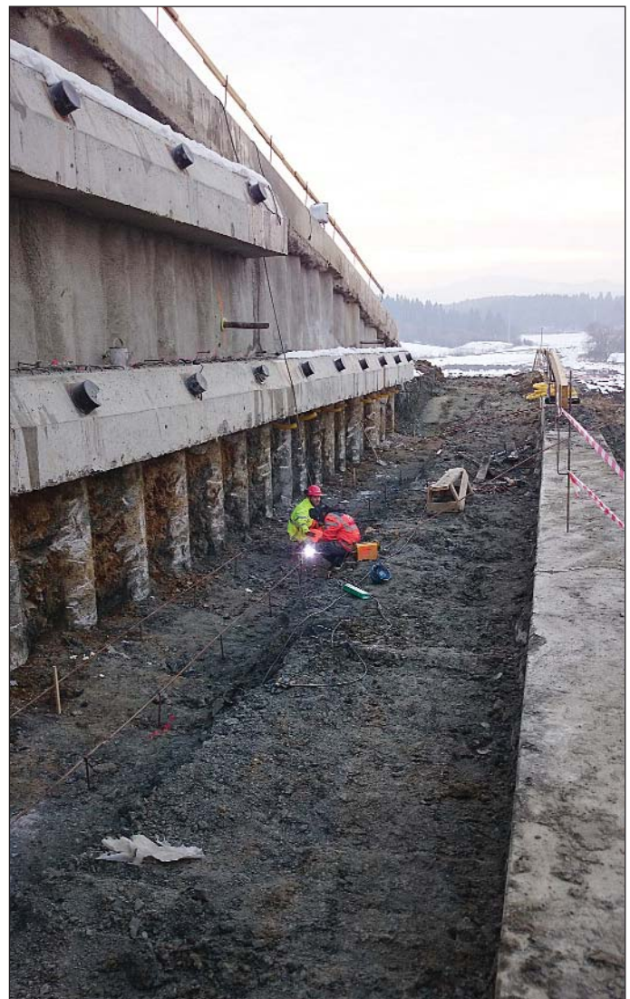
Obr. 1 Práce na prepojovacom tráme medzi dvomi úrovňami pilótovej steny Fig. 1 Work on the interconnecting beam between the two levels of the pile wall
