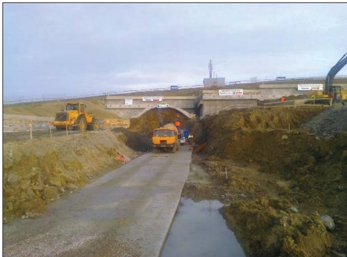
Obr. 1 Začiatok razenia – západný portál Fig. 1 Beginning of tunnel excavation – western portal
