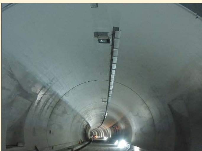
Obr. 7 Tunel Ovčiarsko – sekundárne ostenie Fig. 7 Ovčiarsko tunnel – secondary lining
