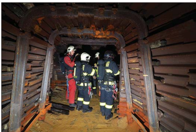
Obr. 5 Stávající přístupová štola Fig. 5 Existing access gallery
