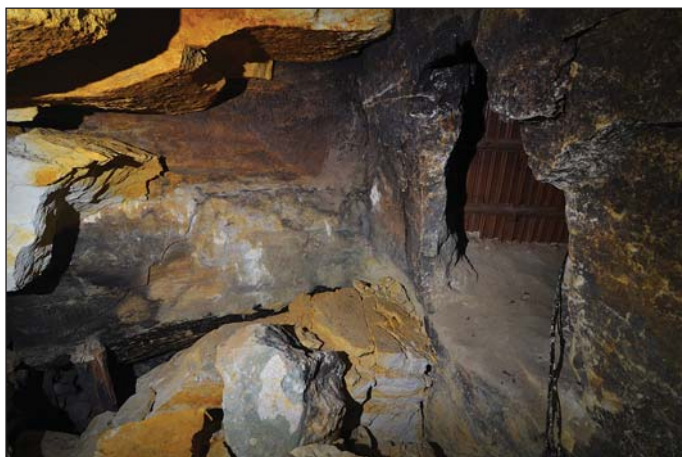
Obr. 4 Kaverna s nestabilním výrubem Fig. 4 Unstable cavern excavation
