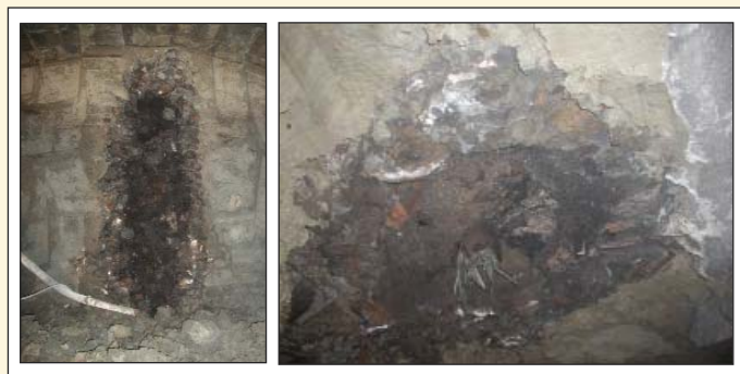
Obr. 6, 7 Studna nafárána v kalotě jižního tunelu Fig. 6, 7 A well stricken at the southern tunnel tube top heading
