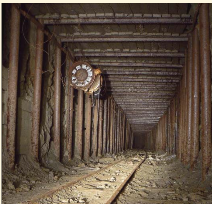
Obr. 5 Dnešní stav štoly Fig. 5 Current condition of the gallery
