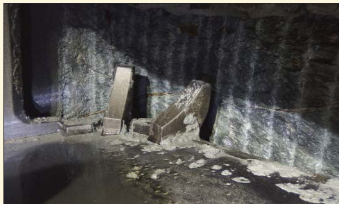
Obr. 9 Příklad čelby ve spilittech Fig. 9 Example of excavation face in spilitte
