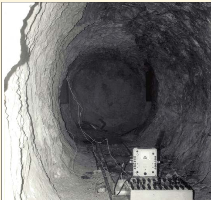
Obr. 3 Tenzometrický profil v průzkumné štolě Viola II Fig. 3 Strain-gauge profile in Viola II exploration gallery
