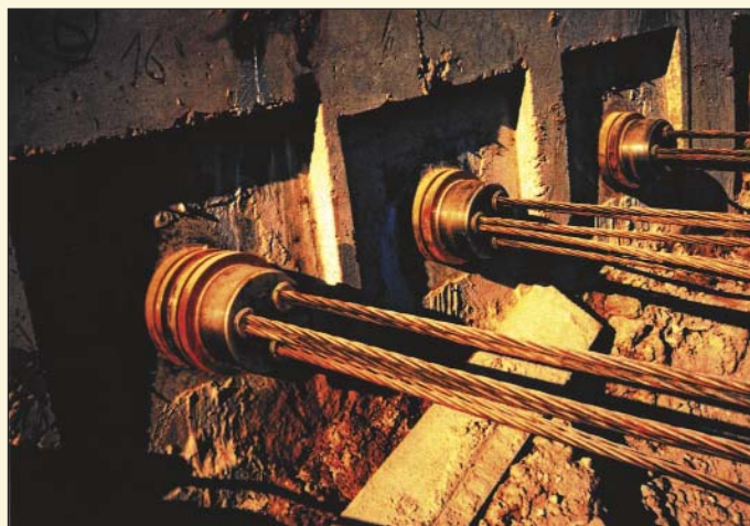
Obr. 4 Část kotev sepínajících masiv (kotva v popředí je osazena tenzometrem) Fig. 4 Part of anchors tying the mass together (a strain gauge is installed on the anchor at the forefront)
