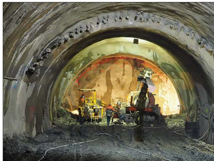
Obr. 4 Pohľad na mikropilótový dáždnik a vrtanie čelbových kotiev Fig. 4 A view of the canopy tube pre-support and drilling for anchors into excavation face
