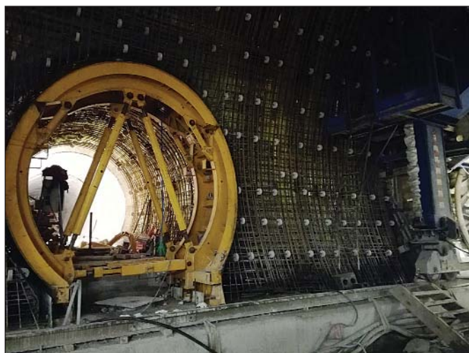
Obr. 7 Pohľad na vystužovanie priečneho prepojenia Fig. 7 A view of a cross passage being reinforced
