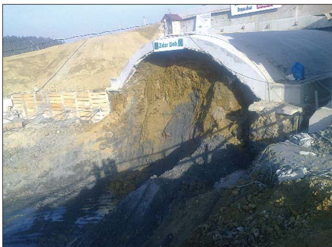
Obr. 4 Ochranná železobetónová klenba „korytnačka“ Fig. 4 Protective reinforced concrete vault, “the tortoise shell”
