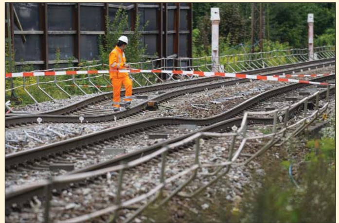
Obr. 1 Nehodou poškozený železniční svršek Fig. 1 Trackwork damaged by the collapse
