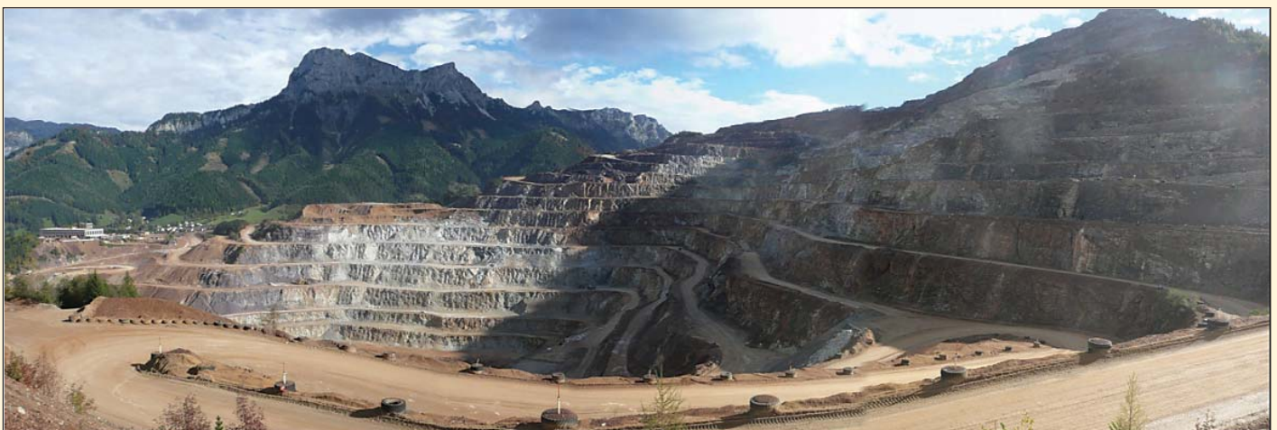
Obr. 1 Pohled na důl od informačního centra Fig. 1 The mine viewed from information centre
