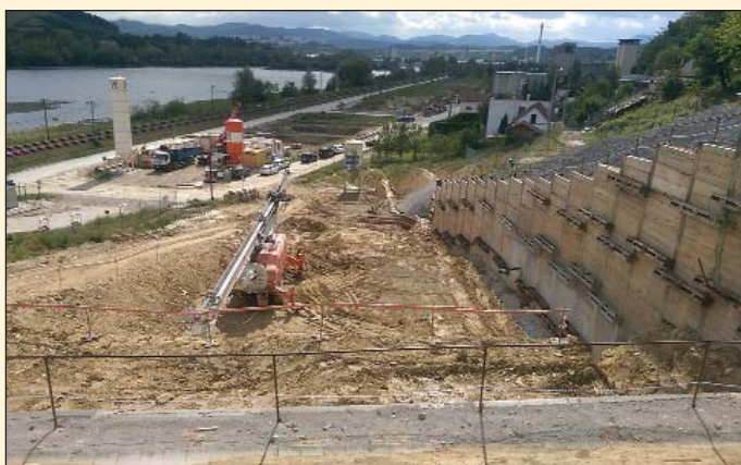
Obr. 3 Tunel Milochov, východný portál Fig. 3 Milochov tunnel, eastern portal
