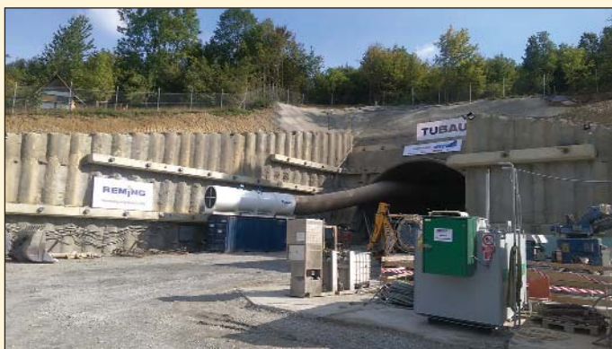
Obr. 1 Tunel Diel, západný portál Fig. 1 Diel tunnel, western portal
