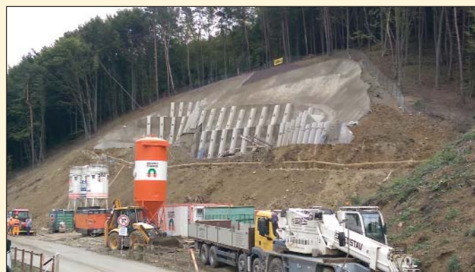
Obr. 2 Tunel Milochov, západný portál Fig. 2 Milochov tunnel, western portal
