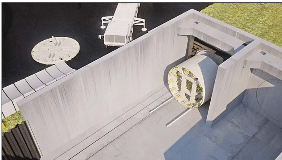
Obr. 2 Virtuální montáž razicího štítu tunelu v pilotním projektu „Tunel Rastatt“ Fig. 2 Virtual assembly of a tunnel boring machine (TBM) in the “Rastatt Tunnel” pilot project
