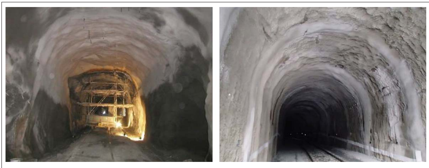
Obr. 3 Aplikace stříkané hydroizolační membrány v Pavlovickém tunelu Fig. 3 Spray-applied waterproofing membrane in the Pavlovice tunnel
