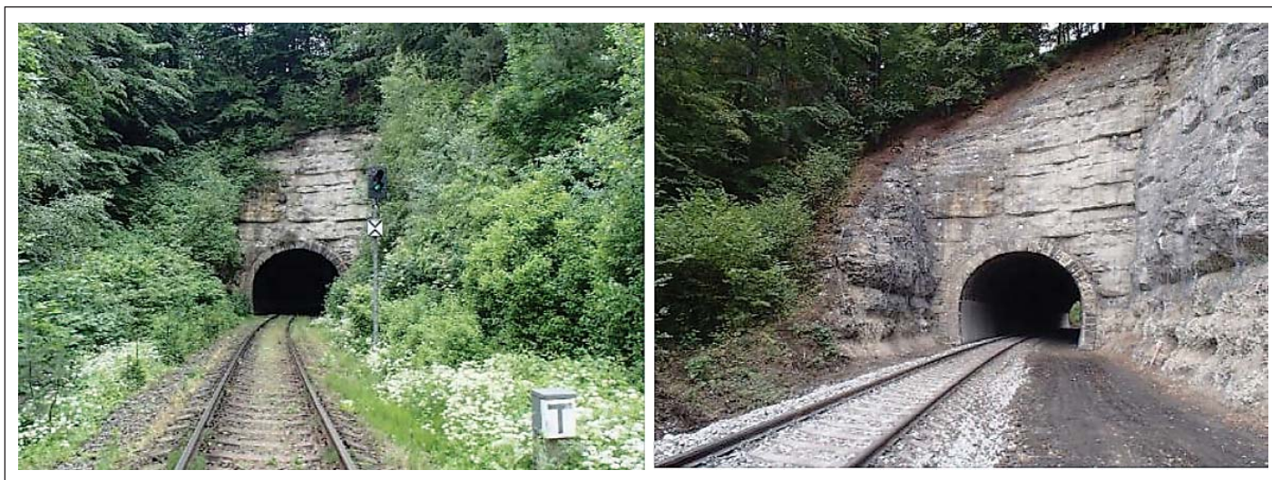
Obr. 4 Sanace Sedlejšovického tunelu – východní portál, vlevo před sanací, vpravo po sanaci Fig. 4 Rehabilitation of the Sedlejšovice tunnel – eastern portal before rehabilitation (for the left) and after rehabilitation (for the right)
