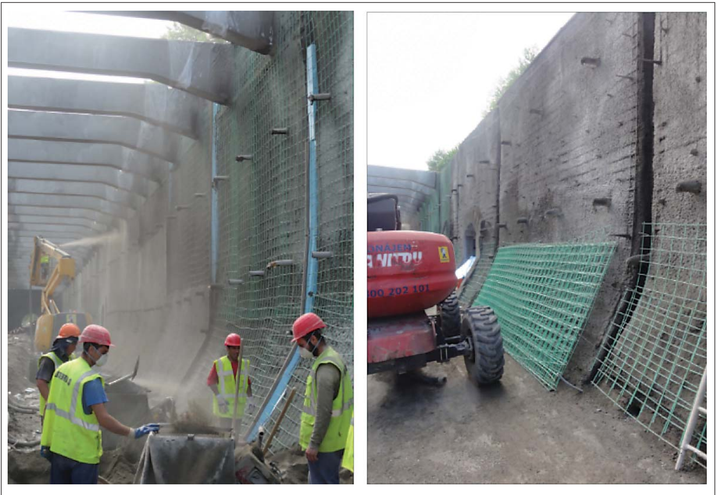
Obr. 2 Sanace Střelenského tunelu s využitím kompozitních sítí Powermesh Fig. 2 Rehabilitation of the Střelenský tunnel using composite Powermesh
