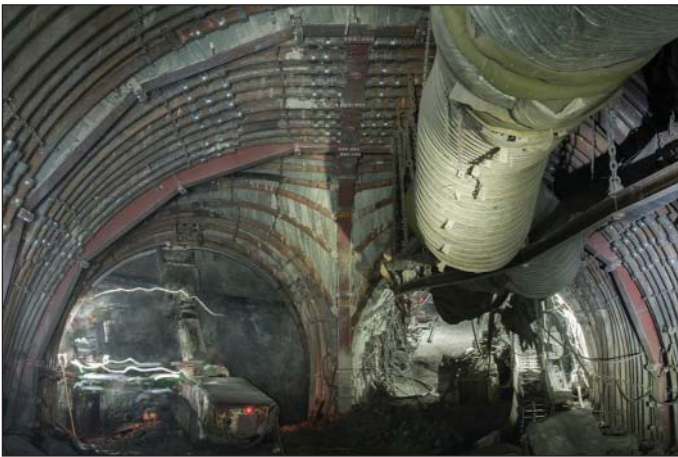
Obr. 2 Příprava ražby odbočky spojovacího překopu č. 01196 na Dole Karviná Fig. 2 Preparation of the excavation of the interconnecting cross tunnel No. 01196 branch at the Karviná Mine
