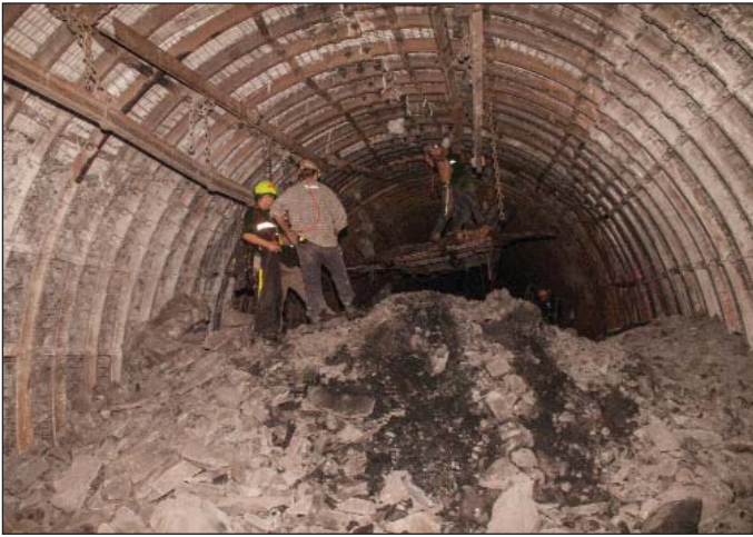
Obr. 9 Místo prorážky protisměrných ražeb Fig. 9 The location of the counter-headings breakthrough
