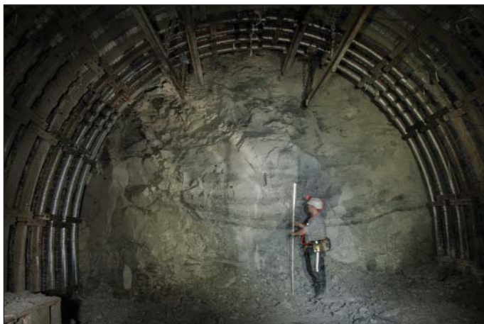
Obr. 4 Geologická struktura čelby spojovacího překopu č. 01196
