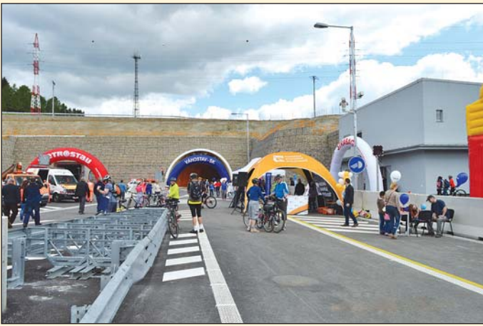
Obr. 1 Den otvorených dverí na stavbe D3 Svrčinovec – Skalité Fig. 1 Open day on Svrčinovec – Skalité section of the D3 motorway
