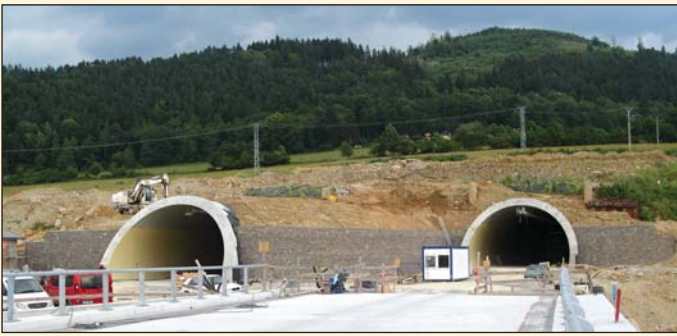
Obr. 2 Tunel Považský Chlmec, západný portál Fig. 2 Považský Chlmec tunnel, western portal
