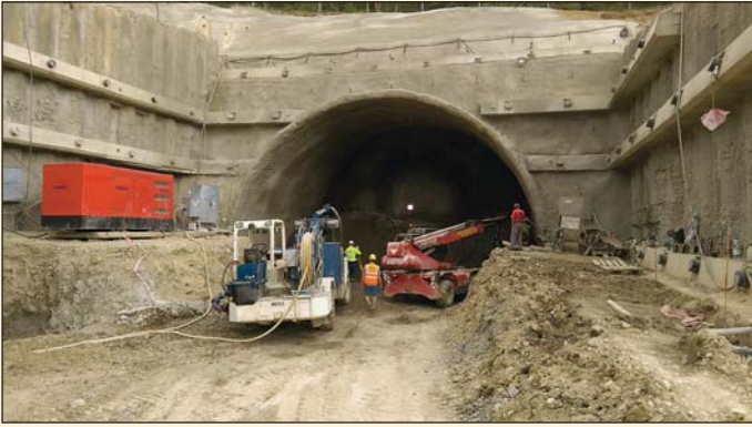
Obr. 4 Zabezpečenie čelnej steny na západnom portáli tunela Diel Fig. 4 Stabilisation of the front wall at the western portal of the Diel tunnel
