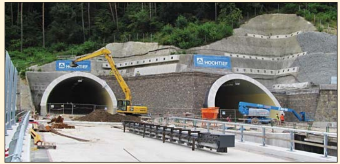
Obr. 3 Tunel Považský Chlmec, východný portál Fig. 3 Považský Chlmec tunnel, eastern portal
