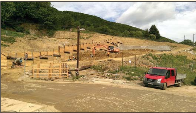
Obr. 5 Oblasť západného portálu tunela Milochovo – odlesnenie Fig. 5 Area of the western portal of the Milochovo tunnel – deforestation
