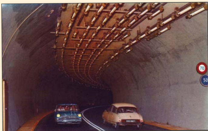
Obr. 5 Tunel Mont Blanc – Courmayeur Chamonix. Délka: 11 600 m. Výška: 5,98 m. Šířka: 8,60 m. Maximální výška skály nad tunelem: 2 480 m. 1966 [sbírka autorů]
