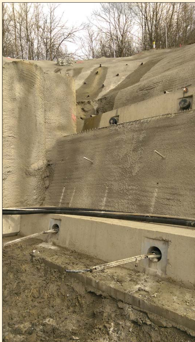
Obr. 5 Zabezpečenie čelnej steny na západnom portáli tunela Diel Fig. 5 Stabilisation of the front end wall at the western portal of the Diel tunnel
