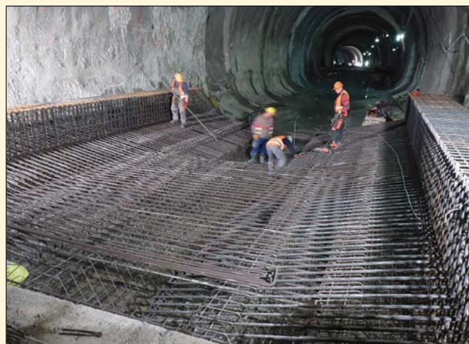
Obr. 2 Tunel Ovčiarisko – armatúra zosilnenej spodnej klenby STR Fig. 2 Ovčiarisko tunnel – steel reinforcement of the thickened NTT invert
