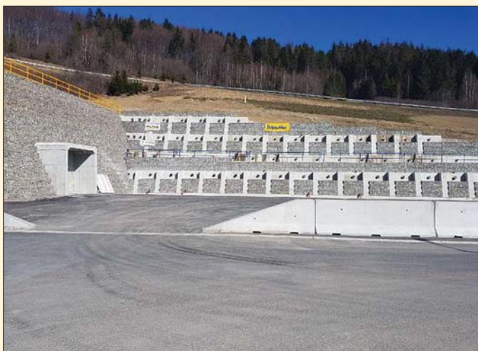
Obr. 1 Tunel Polana – východný portál Fig. 1 Polana tunnel – eastern portal
