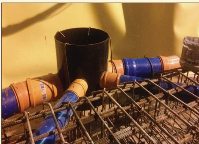
Obr. 3 Tunel Žilina – osadenie dna šachty s napojením drenážnych rúr Fig. 3 Žilina tunnel – installation of a manhole bottom with connections for drainage tubes
