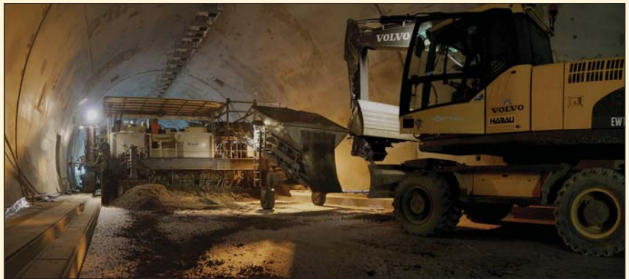
Obr. 4 Tunel Považský Chlmec – betonáž vozovky Fig. 4 Považský Chlmec – concreting the roadway
