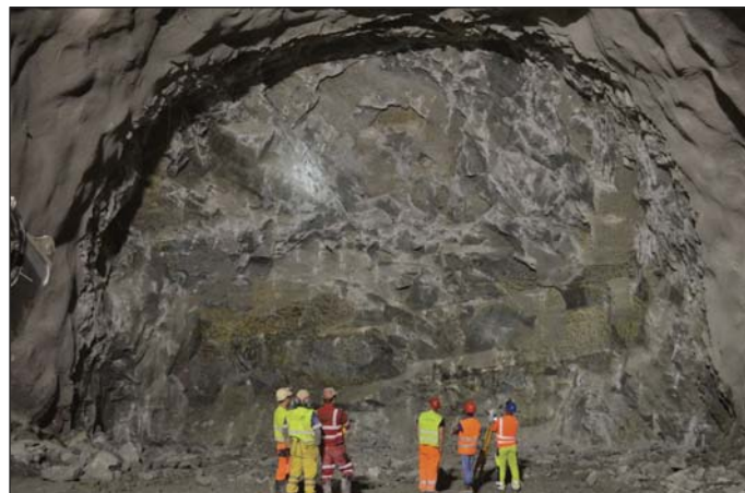
Obr. 9 Razenie profilu núdzového zálivu v horninách kryštalínika od východného portálu Fig. 9 Excavation of the emergency lay-by profile through crystalline rock complex from the eastern portal
