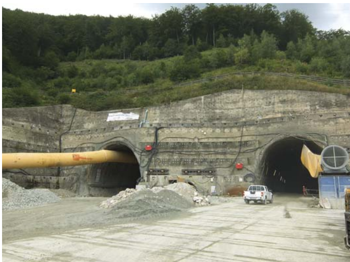
Obr. 8 Východný portál tunela Fig. 8 Eastern portal of the tunnel
