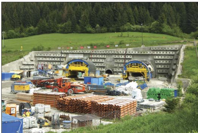
Obr. 2 Západný portál tunela Fig. 2 Western portal of the tunnel
