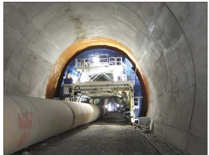
Obr. 12 Betonáž sekundárneho ostenia Fig. 12 Casting of concrete secondary lining
