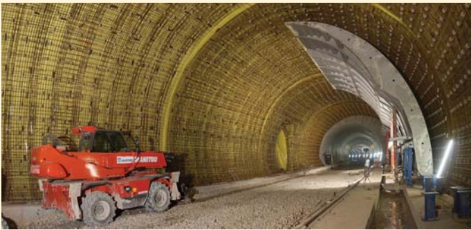
Obr. 1 Tunel Považský Chlmec Fig. 1 Považský Chlmec tunnel
