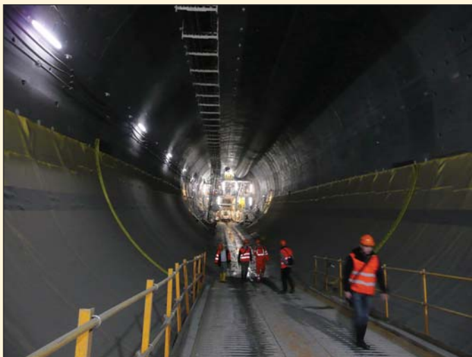
Obr. 4 Švýcarsko – tunel Belchen, pohled směrem k TBM průměru 13,97 m Fig. 4 Switzerland – the Belchen tunnel, a view towards the 13.97m diameter TBM
