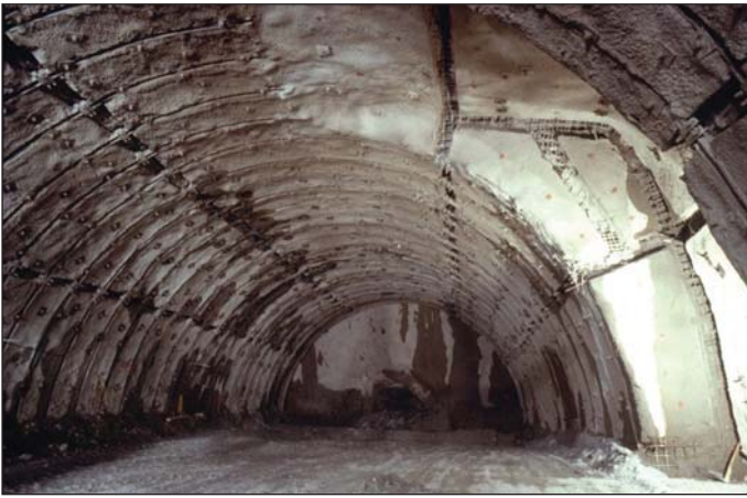
Obr. 3 Otevřené mezery v ostění ze stříkaného betonu na tunelu Inntal v Rakousku
