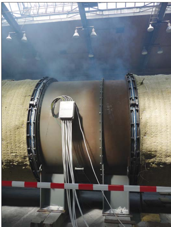
Obr. 5 Zkouška požární odolnosti chodu hlavního ventilátoru pro strojovny odvodu kouře při odvodu spalin o teplotě 400 °C po dobu 90 minut
