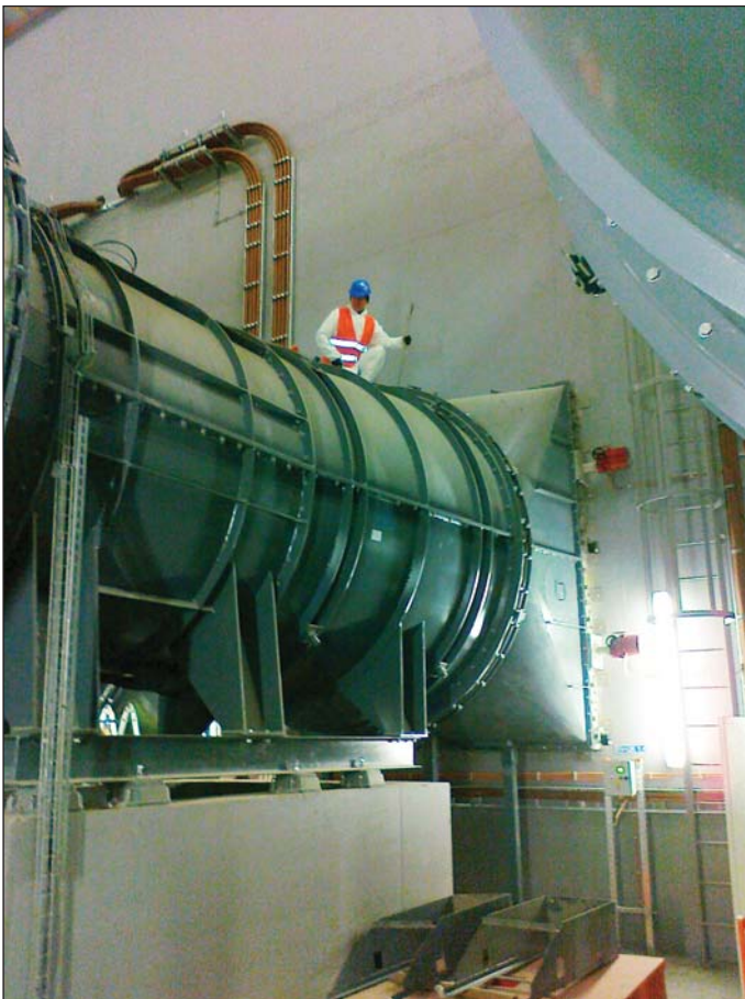
Obr. 6 Měření tlaku na hlavních ventilátorech pro ověření dosažení projektovaných hodnot výkonu odvodu Fig. 6 Measurements of pressure on main fans to verify that design values of the smoke removal are reached
