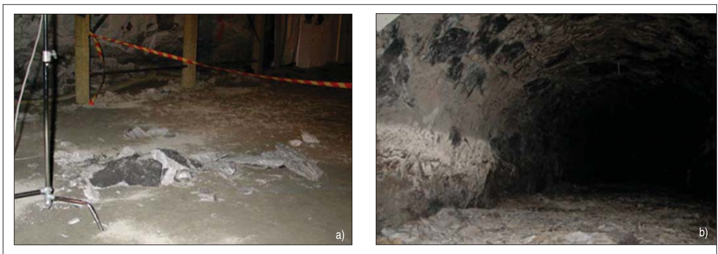
Obr. 9 Padající kusy skály; a) za izolovanou oblastí ve směru proti proudění, b) za izolovanou oblastí ve směru proudění Fig. 9 Falling pieces of rock; a) beyond the insulated area (upstream from the fire), b) beyond the insulated area (downstream from the fire)
