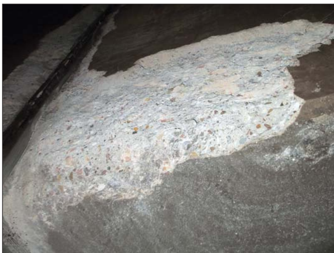
Obr. 10 Poškození betonu požárem
