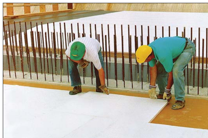
Obr. 13 Ukládání obkladových desek do bednění Fig. 13 Placement of cladding slabs into moulds
