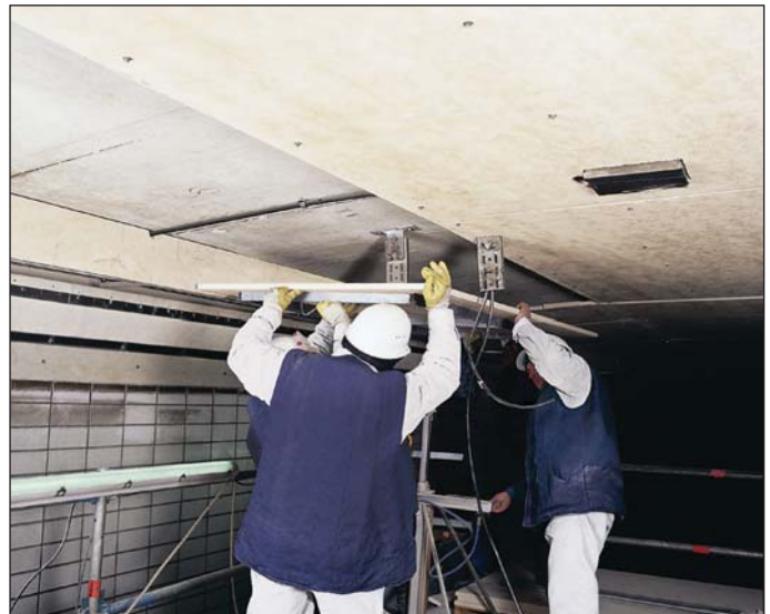
Obr. 14 Dodatečný obklad požárně ochrannými deskami Fig. 14 Additional cladding with fire protection slabs
