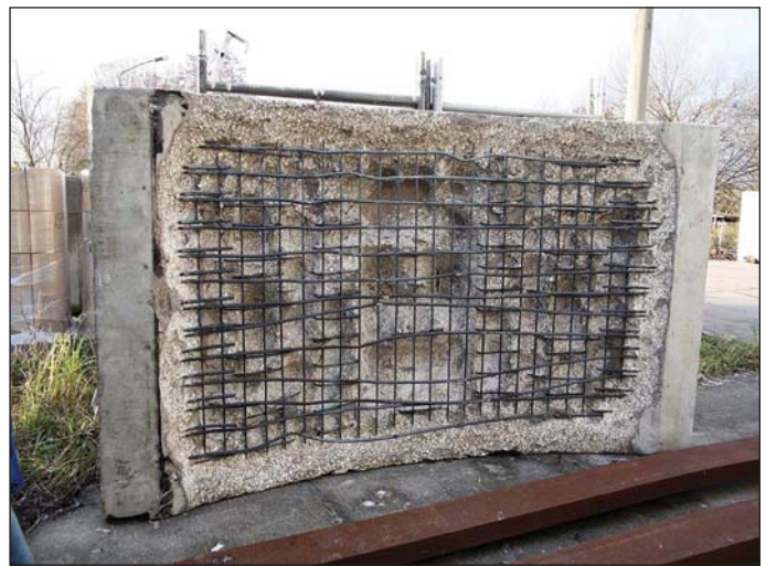
Obr. 3 Ukázka odprýskaného betonu až po ocelovou výztuž Fig. 3 Demonstration of concrete flaked off up to steel reinforcement
