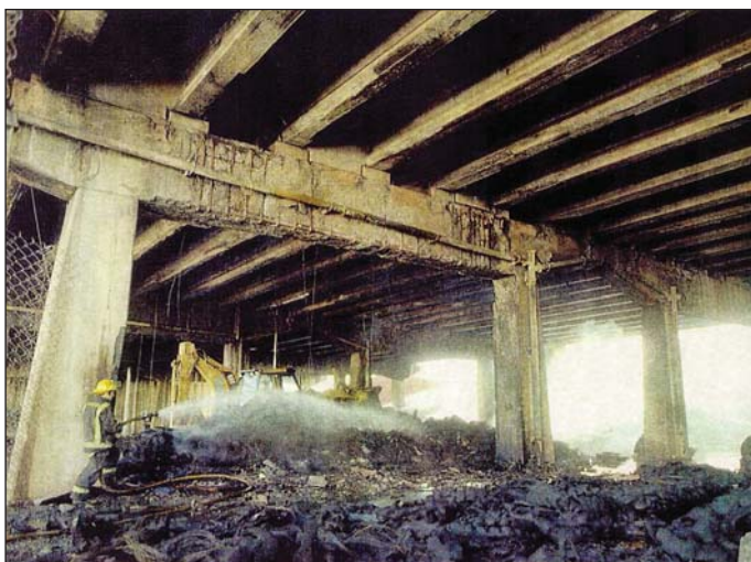
Obr. 4 Oprýskání betonu až na nosnou výztuž Fig. 4 Concrete suffering spalling up to the depth of the bearing reinforcement
