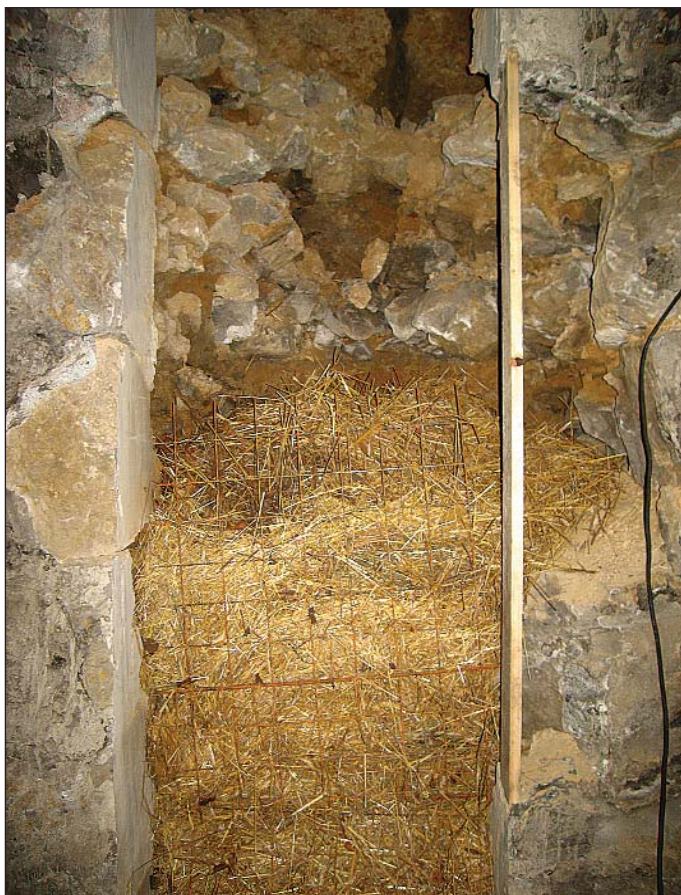
Obr. 6 Slámová drenážní vrstva s výztužnou a přídržnou KARI sítí Fig. 6 Straw drainage layer with the reinforcing and holding KARI mesh
