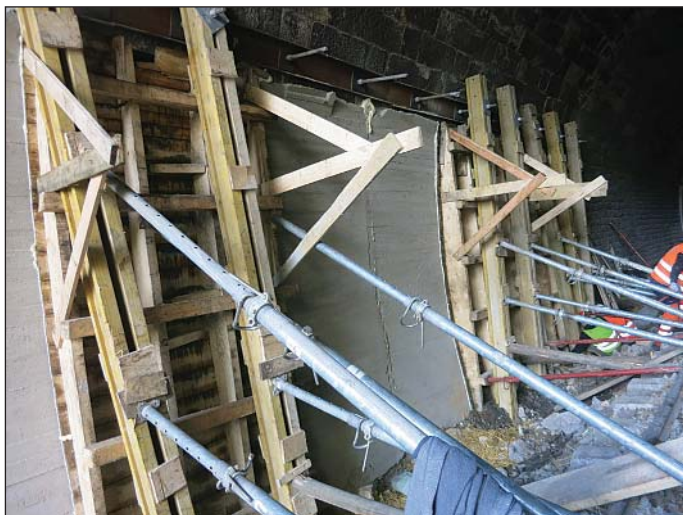
Obr. 8 Nově betonované pruhy ostění, příložné bednění se vzpěrami, hotová betonová opěra po odbednění v pásu č. TP6
