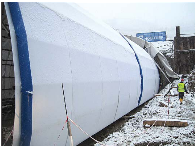
Obr. 6 Nafukovací manžety a tepelně izolační plášť „klíma“ vozu
