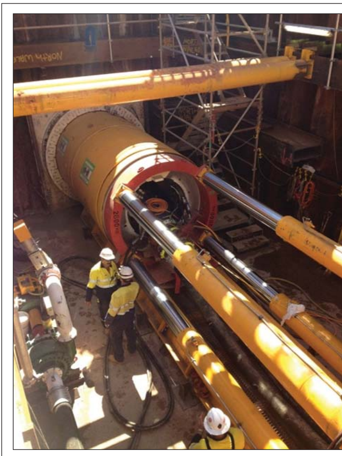
Obr. 14 Protlačovací stanice, pohled zevnitř tunelu Fig. 14 Double Jacking Station / View Inside the Tunnel
