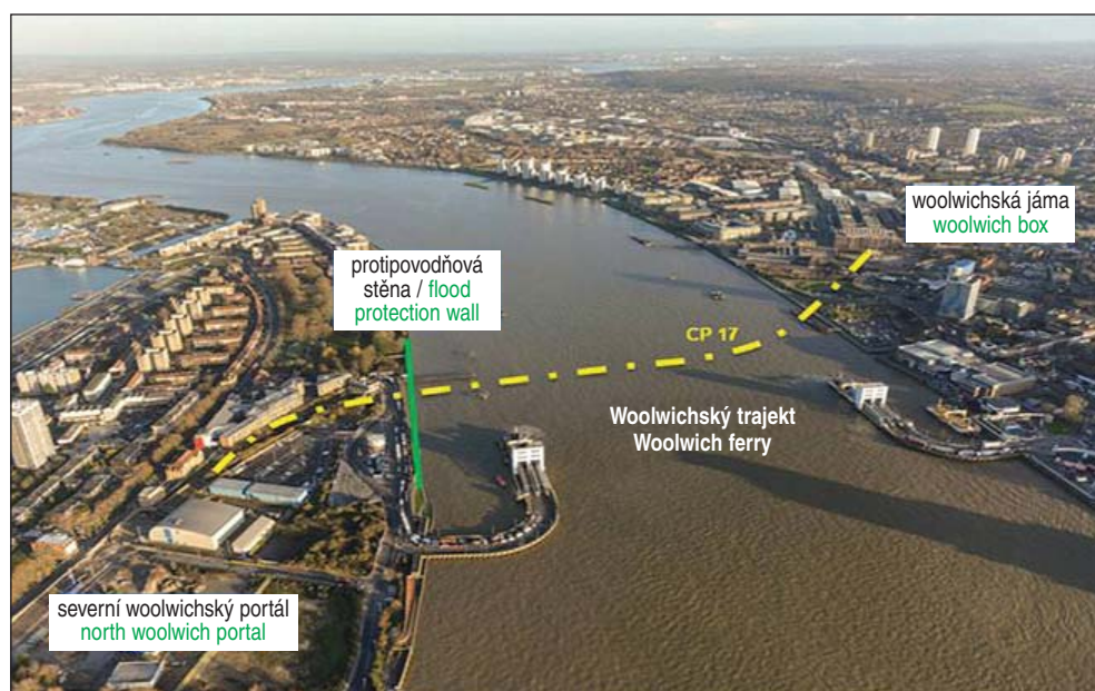
Obr. 3 Letecký snímek ražeb pod řekou Temží Fig. 3 Tunnelling underneath the River Thames
