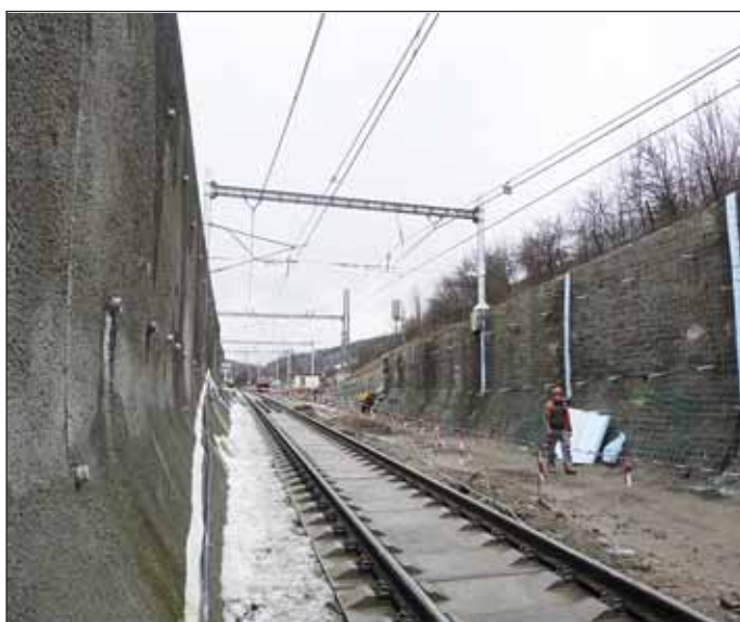
Obr. 3 Sanace předportálové zárubní zdi Fig. 3 Rehabilitation of pre-portal revetment walls
