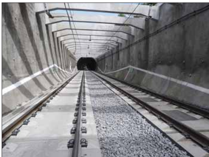
Obr. 6 Dokončená pevná jízdní dráha v předportáli tunelu z české strany Fig. 6 Finished slab track in the tunnel pre-portal area on the Czech side
