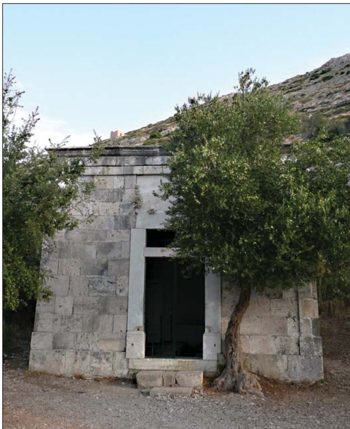
Obr. 8 Jižní vstupní portálek nad přístupovou chodbou do tunelu/štol Fig. 8 The southern little access portal above the access adit to the tunnel
