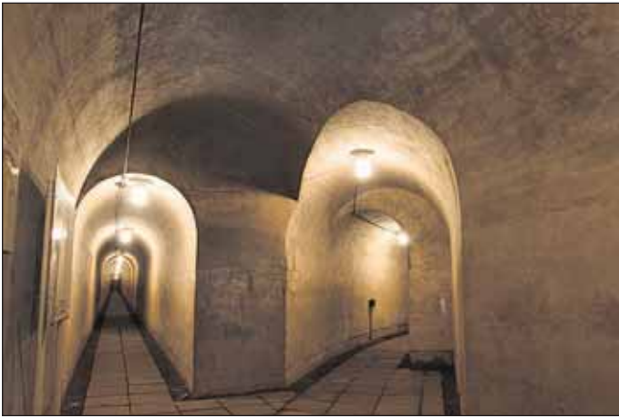
Obr. 13 Odbočka chodeb profilu 150/275 v podzemí tvrze Dobrošov s definitivním ostěním; součást prohlídkového okruhu Fig. 13 A branch of 150/275-profile galleries in the Dobrošov fortress underground with the final lining installed - part of the guided tour
