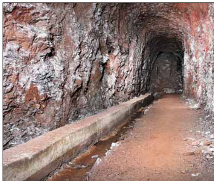
Obr. 3 Vybetonovaný základ ostění v podzemí tvrze Dobrošov Fig. 3 Completed concrete foundation of the lining in the Dobrošov fortress underground
