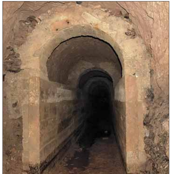
Obr. 12 Nedokončené ostění chodby profilu 150/275 v podzemí tvrže Dobrošov; krátké úseky klenby pravděpodobně dočasně stabilizovaly výrub, mezilehlé části klenby měly být betonovány dodatečně
