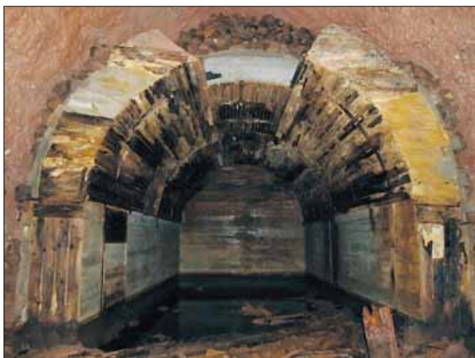
Obr. 8 Pozůstatky bednění sálu profilu 400/400 v podzemí tvrže Stachelberg; v popředí fragment stojky z výdřevy, zajišťující výlom provedený v sousedním pasu Fig. 8 Remains of formwork for a 400/400-profile hall in the Stachelberg fortress underground. A fragment of a timbering post supporting the excavation completed in the neighbouring block can be seen in the foreground
