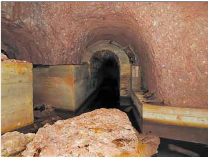
Obr. 5 Ostění v různých fázích výstavby v podzemí tvrže Stachelberg Fig. 5 Linings in various phases of the construction in the Stachelberg fortress underground
