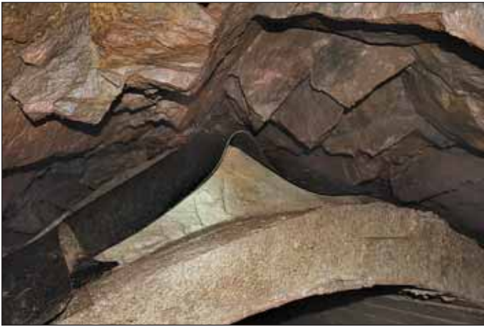
Obr. 18 Betonový „hřeben“ s izolací z lepenkových pásů na klenbě ostění hlavní galerie tvrze Dobrošov
