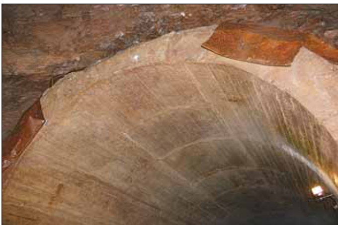
Obr. 17 Izolace s použitím plechů na klenbě ostění sálů kasáren tvrze Dobrošov; ze snímku jsou také poměrně dobře patrné zkrácené záběry betonáže vrchlíku klenby
