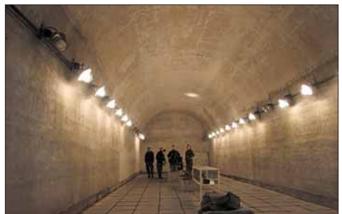
Obr. 15 Muniční sál profilu 520/460 v podzemí tvrze Dobrošov s definitivním ostěním; součást prohlídkového okruhu Fig. 15 A 520/460-profile ammunition store room in the Dobrošov fortress underground with the final lining installed - part of the guided tour
