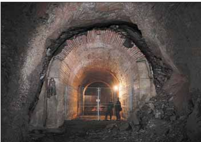
Obr. 11 Kombinované ostění z prostého betonu a pálených cihel v sále kasáren tvrže Dobrošov; nad klenbou jsou patrné izolační asfaltové pásy Fig. 11 Combined linings formed by non-reinforced concrete and burned brick in a hall of the Dobrošov fortress barracks. Waterproofing asphalt cardboard sheet can be seen above the vault
