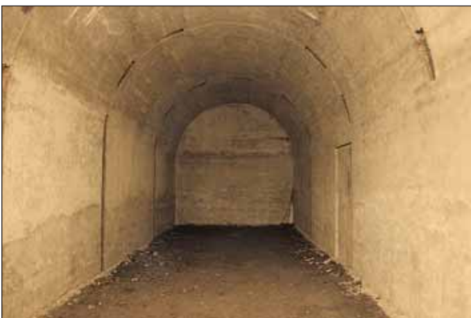
Obr. 14 Sál profilu 400/440 v podzemí tvrze Dobrošov s definitivním ostěním; podlaha nebyla vybetonována, v „kapsách“ ostění měly být fixovány cihelné příčky Fig. 14 A 400/440-profile hall in the Dobrošov fortress underground with the final lining installed. The concrete floor concreting was not carried out. Brick partitions were to be fixed in mortises in the lining
