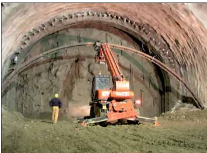
Obr. 5 Osádzanie oblúkového nosníka Fig. 5 Installation of a steel arch
