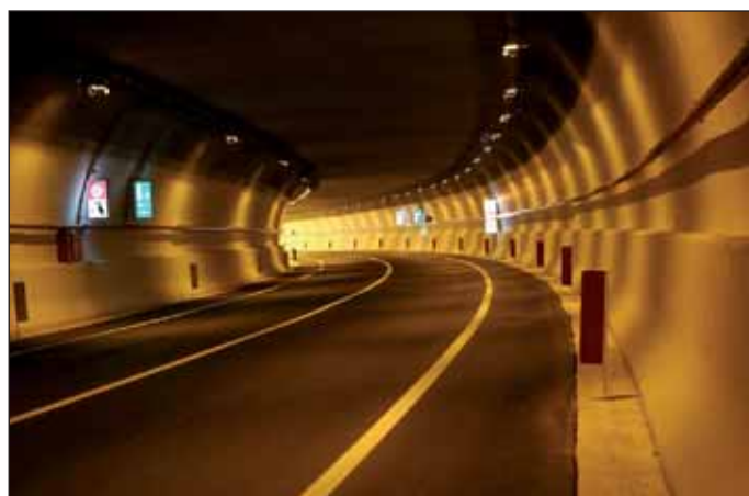
Obr. 6 Tunel Monte Cuneo po dokončení Fig. 6 Monte Cuneo Tunnel after completion
