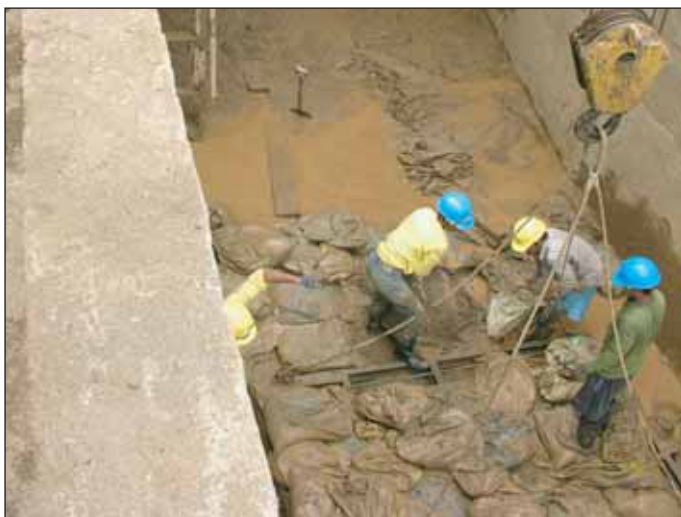
Obr. 8 Pohled na ruční čištění nápuštěného kanálu vstupu tunelu Fig. 8 A view of the manual cleaning of the feeding canal at the tunnel intake structure
