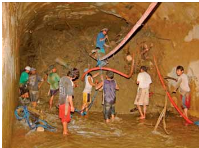
Obr. 9 Pohled na ruční čištění výtoku zaneseného tunelu (foto firmy EDCOP 2005) Fig. 9 A view of the manual cleaning of the outlet of the silted tunnel (photo by EDCOP 2005)
