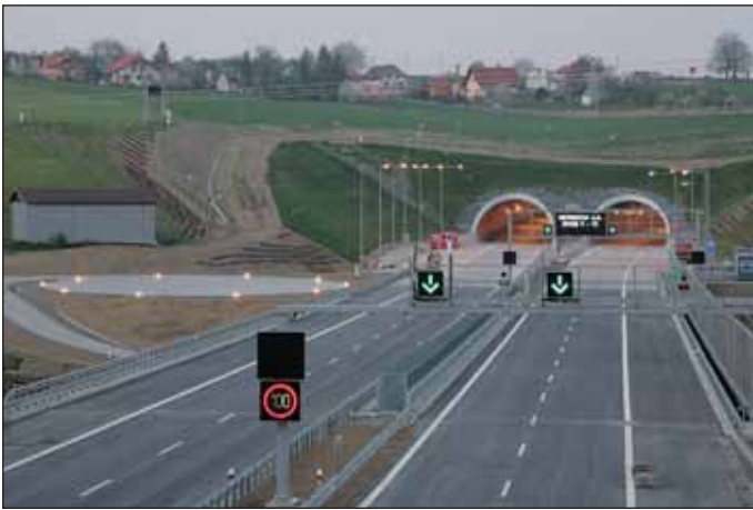
Obr. 4 Brněnský portál s osvětlením plochy pro zásah IZS Fig. 4 The Brno portal with the illumination of the IRS mustering area
