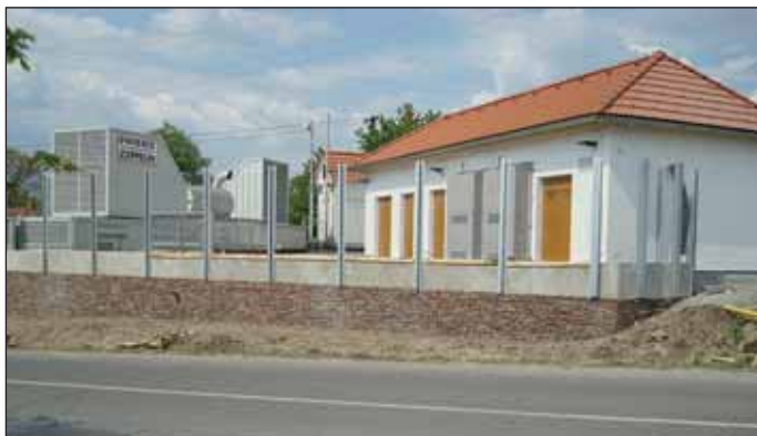
Obr. 2 Trafostanice a kontejner záložního zdroje Fig. 2 The transformer station and the stand-by power source container
