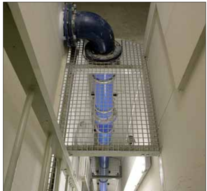
Obr. 5 Kabelová šachta s požárním vodovodem do tunelové propojky 3 Fig. 5 The cable shaft with the fire main leading to the cross passage TS3
