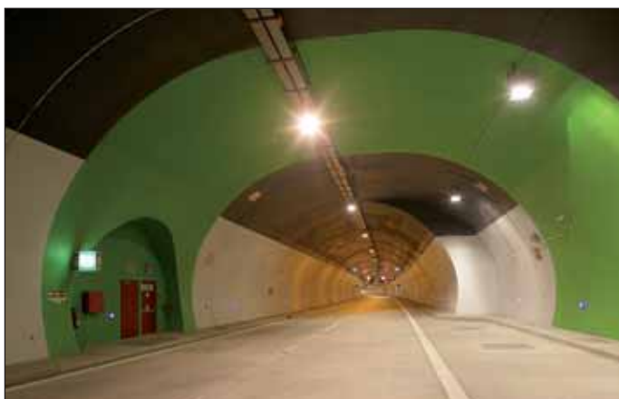
Obr. 3 Osvětlení nouzového zálivu a vstupu do tunelové propojky Fig. 3 The lighting of the emergency lay-by and an entrance of a cross passage
