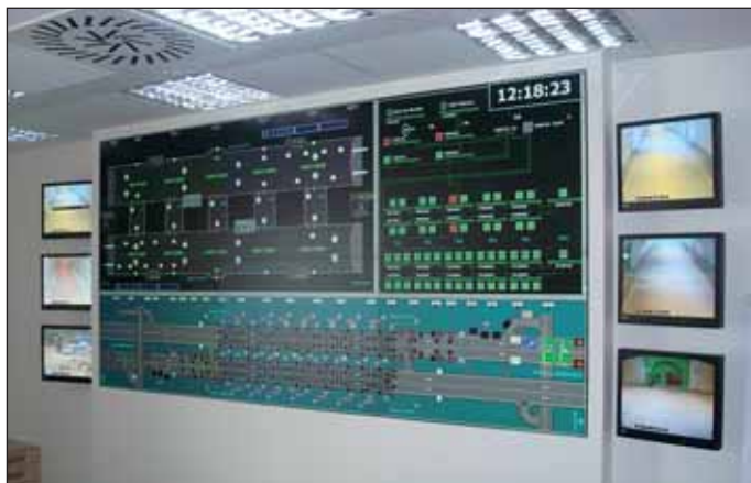
Obr. 1 Velkoplošný zobrazovací systém s monitory videodohledu Fig. 1 The large-area projection system with TV surveillance screens
