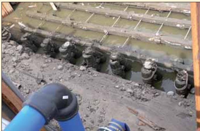
Obr. 6 Obnažené dřevěné základové piloty starých nábrežních zdí Fig. 6 Exposed timber pile foundations of old embankment walls
