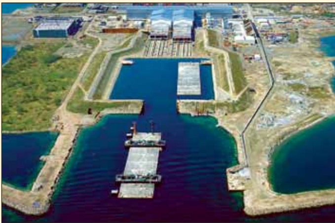
Obr. 9 Jeden z tunelových dílů po vytažení z výroby
