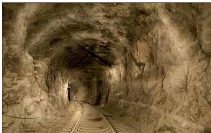
Obr. 2 Hlavní část tunelu je ponechána bez ostění Fig. 2 The main part of the rock excavation is left unlined
