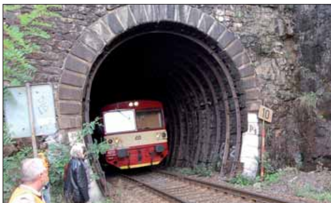
Obr. 3 Portál a prvních 40 m s provizorním zajištěním Fig. 3 The portal and initial 40m with a temporary support
