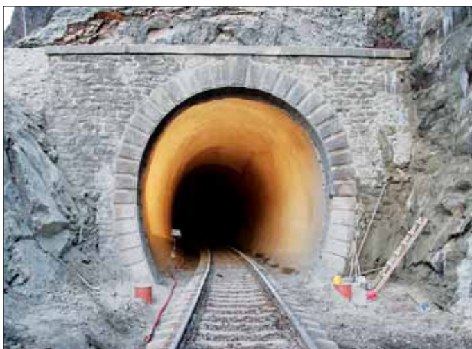
Obr. 6 Rekonstruovaný tunel Fig. 6. The tunnel after reconstruction
